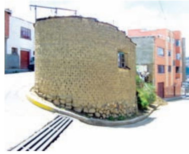
Diversidad de materiales de construcción, antes el adobe, hoy en día el hormigón armado.
