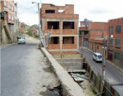
Aspectos de una vía que serpentea en la zona de Villa de la Cruz.
