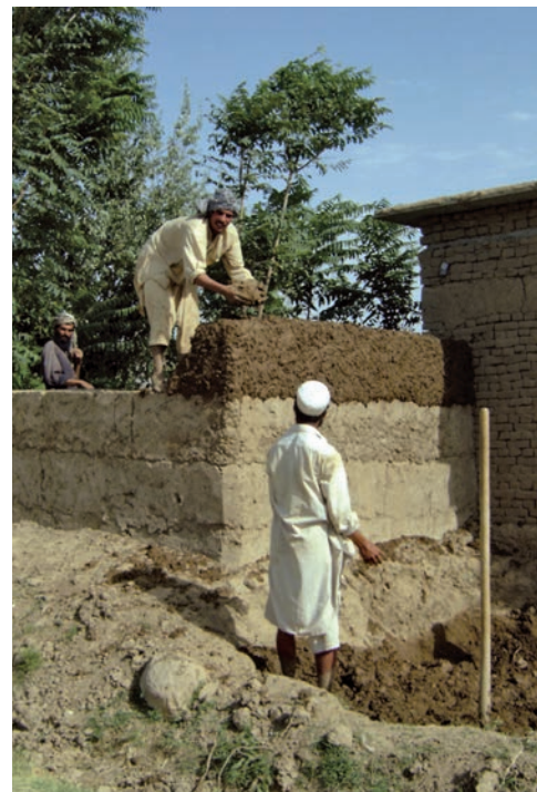
Figura 41. Construcción con barro.
