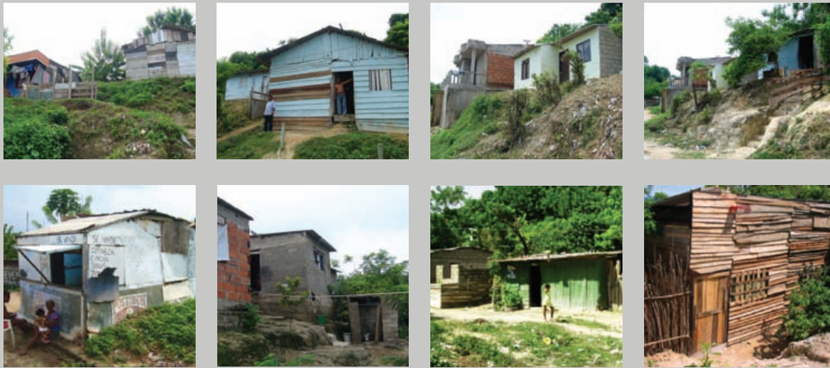
Figuras 23-30. Zona caracterizada por pendientes pronunciadas e inminencia de deslizamiento de tierra.
