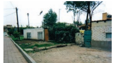
Figura 13. Vivienda sin consolidar, se identifican diferencias de nivel entre calles y viviendas (Espínosa, 2000).
