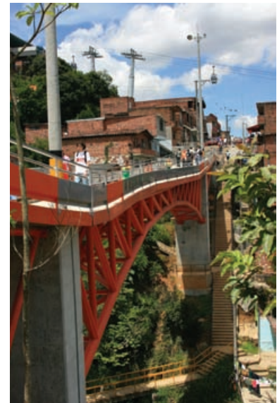
Figura 27. Puente en la quebrada de Juan Bobo. Foto: del autor.
