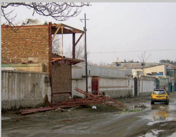
Figura 43. También en los barrios de clase media hay construcciones sin permiso y calles no pavimentadas.
