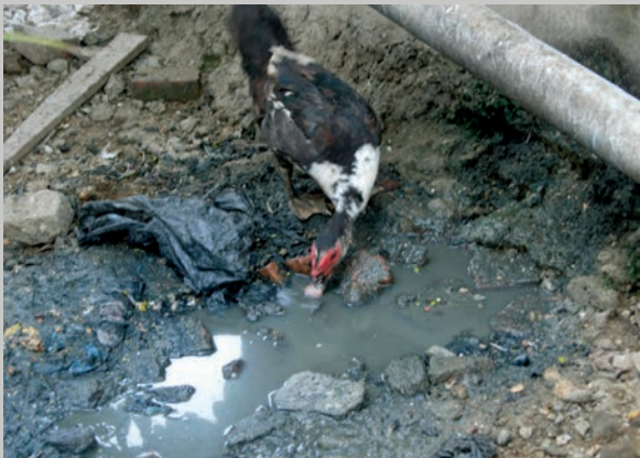
Figura 10, 10a y 10b. Banda Aceh: desagüe de aguas negras, el terreno está más bajo que la calle. (Foto: Ibid. ).
