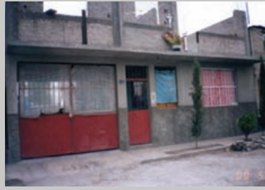
Figura 20. Vivienda en transición, inclusive se inicia la construcción de un segundo nivel (Espinosa, 2000).
