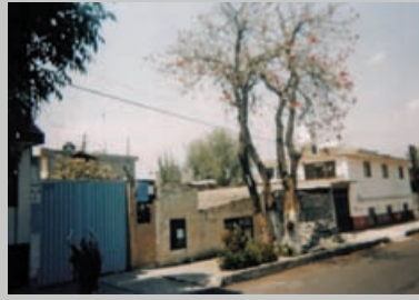
Figura 7. Vivienda sin consolidar, ventanas al nivel de la banqueta (Espinosa, 2000).
