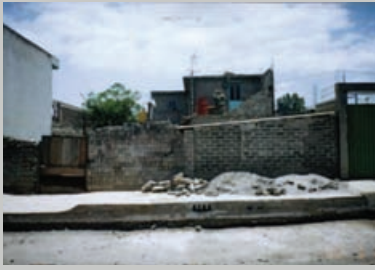
Figura 19. Vivienda sin consolidar "fachadas ciegas", sin ventanas y una puerta de acceso (Espinosa, 2000).
