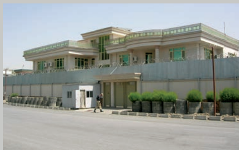
Figura 48. Casa con todos los requisitos de seguridad.
