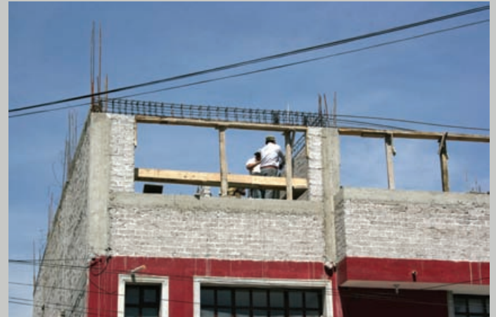
Figura 9. Construcción progresiva ciudad de México.
