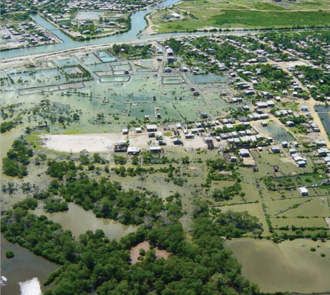
Figura 1. Asentamiento informal en la periferia oriental de Cartagena (zona en riesgo constante de inundación). Fuente: Fundación ECOS, 2007.
