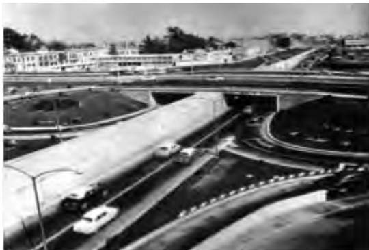
Imagen 2.6. Viaducto Miguel Alemán, circa de 1954.
