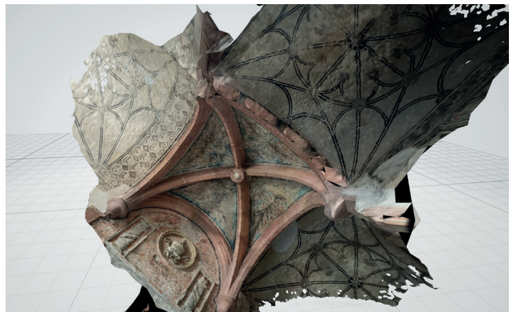
Modelo 3D mediante fotogrametría. Detalle de bóveda en claustro. Autor: Moisés Bustos.
