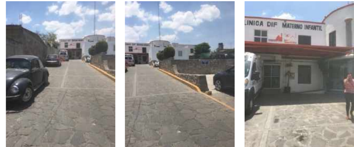
Figura 28. Fotografías del estado actual de la Clínica DIF. Fuente: Elaboración propia.
