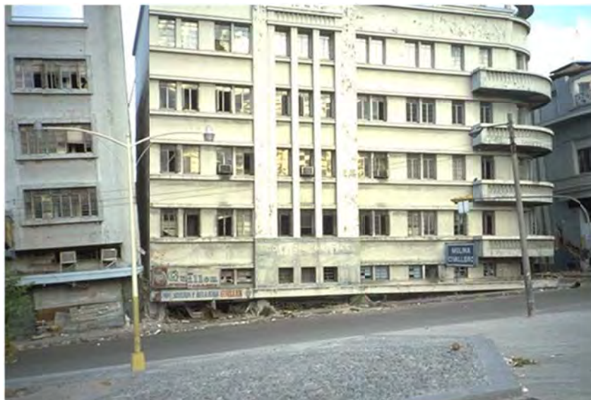
Figura 6.5 Colapso del nivel inferior del Edificio Dueñas (Anderson 1987)
