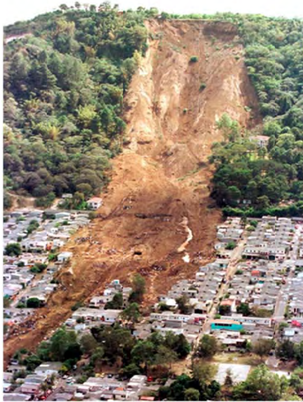
Figura 6.7 Deslizamiento de talud, Residencial Las Colinas (Bommer 2001)
