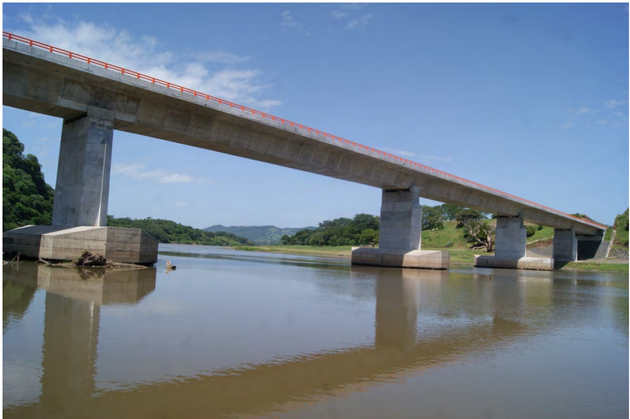
Figura 7.3 Vista del puente desde el río Lempa, en operación
