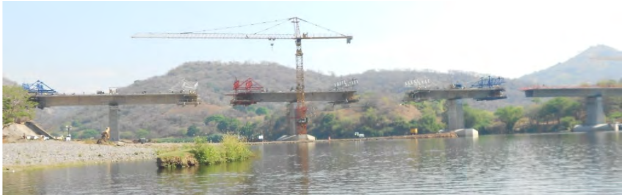
Figura 7.2 Vista del puente desde el río Lempa, etapa de construcción
