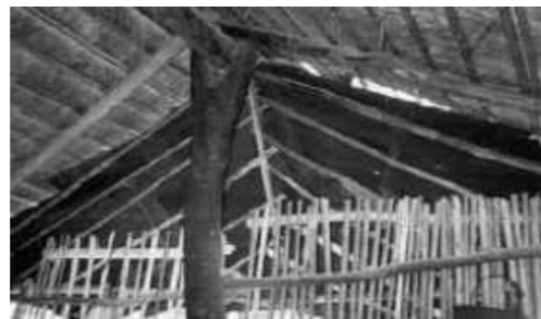
Ilustración 24. Pie derecho interior en una casa con estructura de torito y cubierta de zacate. Fuente: Adecuación al medio ambiente de la arquitectura del Siglo XVIII en la Antigua Provincia de Colima.
