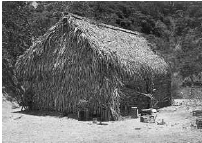
Ilustración 35. Muros y cubierta de palma de Cayaco en el poblado de Emiliano Zapata. Fuente: Adecuación al medio ambiente de la arquitectura del Siglo XVIII en la Antigua Provincia de Colima.
