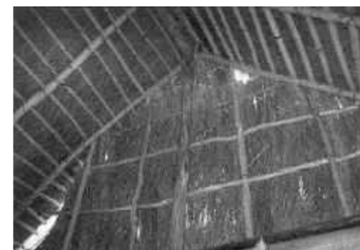
Ilustración 30. Cubierta de zacate con estructura de torito. Fuente: Adecuación al medio ambiente de la arquitectura del Siglo XVIII en la Antigua Provincia de Colima.
