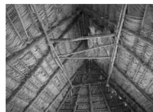
Ilustración 32. Cubierta de palpa con estructura de mono. Fuente: Adecuación al medio ambiente de la arquitectura del Siglo XVIII en la Antigua Provincia de Colima.
