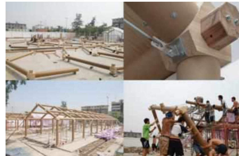
Ilustración 72. Etapa constructiva de Hualin Temporary Elementary School - Chengdu, China, 2008. Fuente: architectureexposed.com
