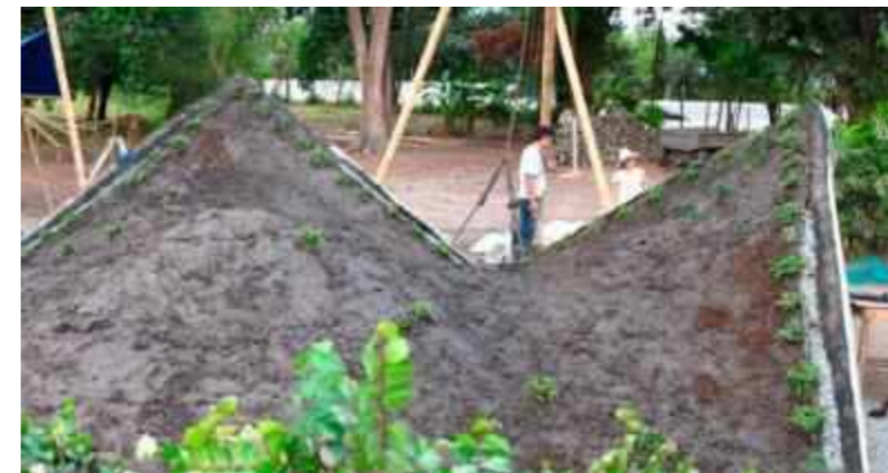
Ilustración 131. Ejemplo de cubierta verde, manto vegetal de 10 a 15 cm, con plantas autóctonas, estructura reglada. Fuente: Gemot Minke y Jorg Stamm (Bambusa)
