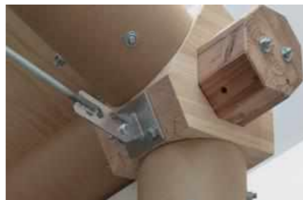
Ilustración 127. Nodos de madera de cedro, utilizados como elementos de unión para las traveses y columnas de bambú.
