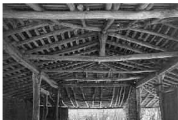
Ilustración 31. Cubierta de teja con estructura diagonal en el poblado de Tinajas, Colima. Fuente: Adecuación al medio ambiente de la arquitectura del Siglo XVIII en la Antigua Provincia de Colima.
