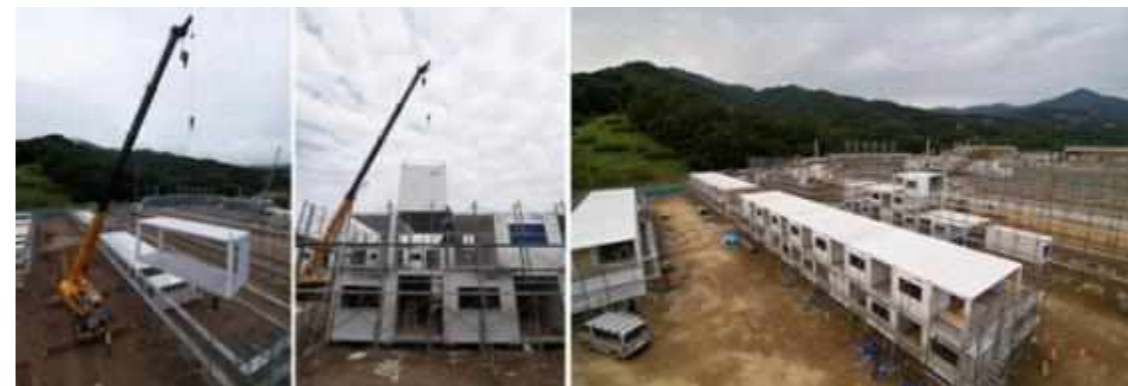
Ilustración 75. Etapa constructiva proyecto Container Temporary Housing – Onagawa, Miyagi, 2011. Fuente: world-architects Review
