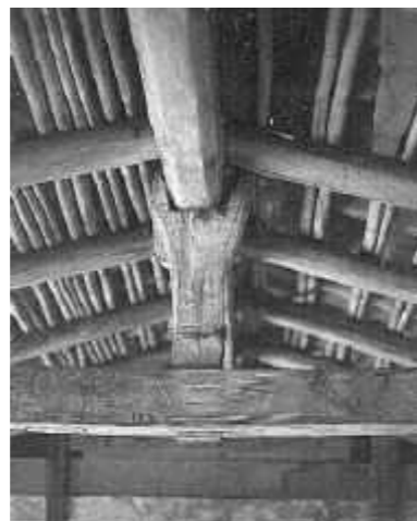
Ilustración 25. El dominguejo cuartonado, de una casa de torito, transmite la carga del caballete a una cadena sobre la cual se empotra. Fuente: Adecuación al medio ambiente de la arquitectura del Siglo XVIII en la Antigua Provincia de Colima.
