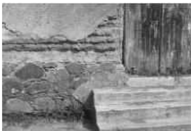
Ilustración 27. Cimentación de piedra para muros de adobe en Villa de Álvarez. Fuente: Adecuación al medio ambiente de la arquitectura del Siglo XVIII en la Antigua Provincia de Colima.
