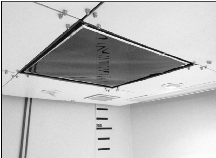
Figura 68. Difusor con el filtro montado en el plafón.
