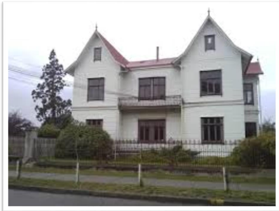
Fotografía 16. Tipología de casas estilo alemán en Valdivia. Fachada casa Commentz Hoffmann. Fotografía: www.ciudadvaldivia.cl
