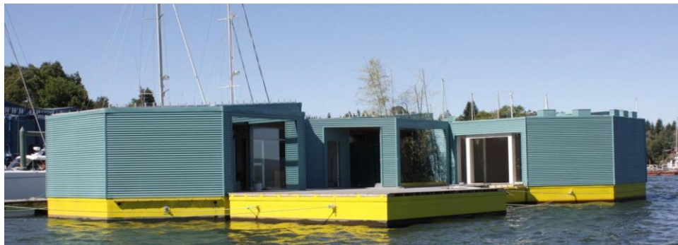
Fotografía 12. Construcción modular del “barrio Flotante”
