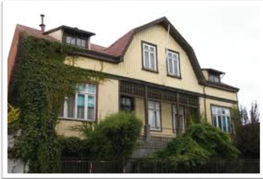
Fotografía 15. Tipología de casas estilo alemán en Valdivia. Fachada casa Bukhardt Hoffmann. Fotografía: www.ciudadvaldivia.cl
