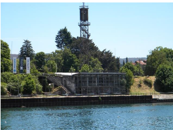
Fotografía 10. Fachada del MAC, ex cervecería Anwandter, ribera oeste, sector Isla teja. Fuente: M. Rojas Novoa
