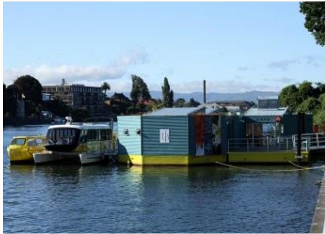
Fotografía 11. Proyecto “Barrio Flotante” y “taxis Fluviales”, ribera oeste, sector Isla Teja. Fuente: www.elnavegable.cl
