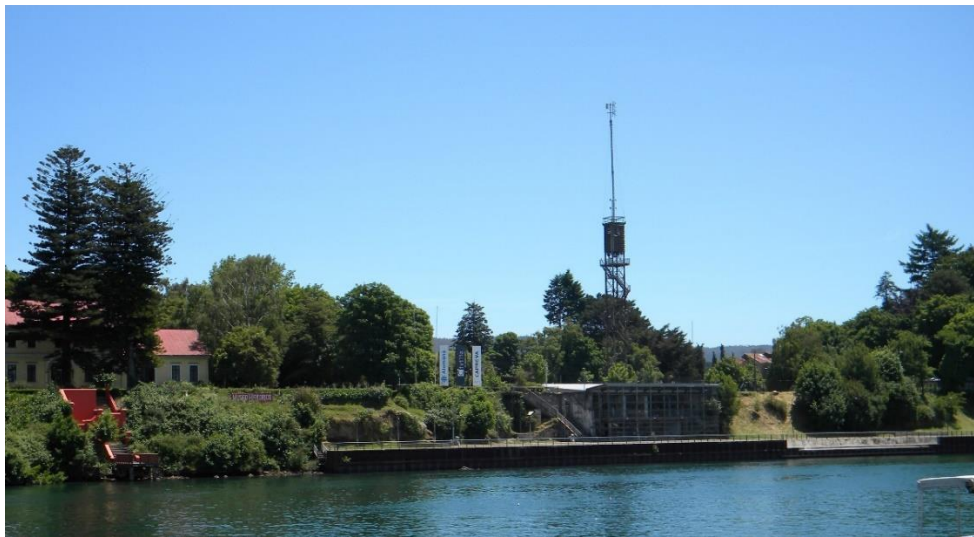
Fotografía 8. Vista general a la “Costanera Cultural”, ribera oeste, sector Isla teja, Museo Histórico y MAC. Fuente: M. Rojas Novoa
