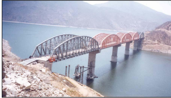
Figura 1.2 Fotografía del puente Infiernillo (SCT, 2002)
