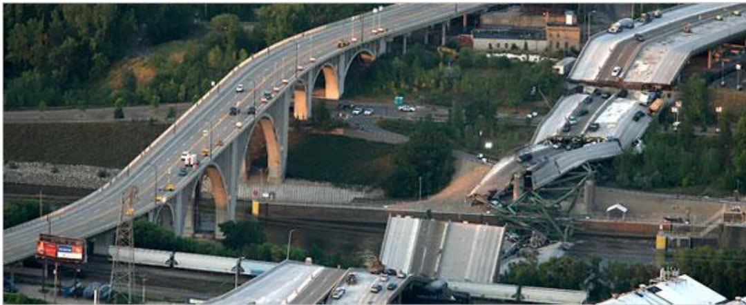
Figura 1.1: Minnesota bridge [New York Times (01 de Agosto de 2007)]
