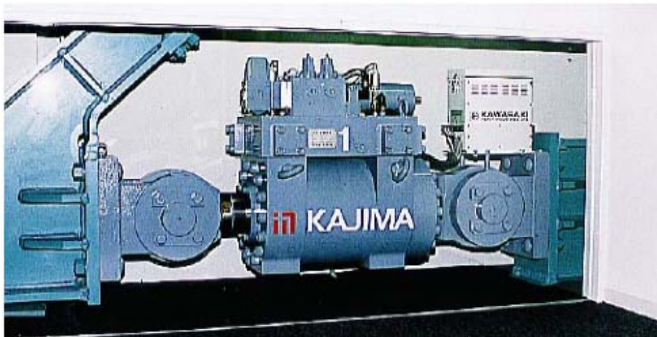
Figura 1.15 Amortiguador de orificio variable implementado en edificio Shizuoka Japón
