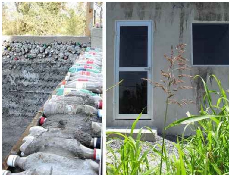
Figura 2.10 Construcción desarrollada por el CIDETEQ de pet y paja en Qro.
