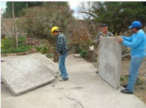
Figura 3.20 Colocación panel sur.
