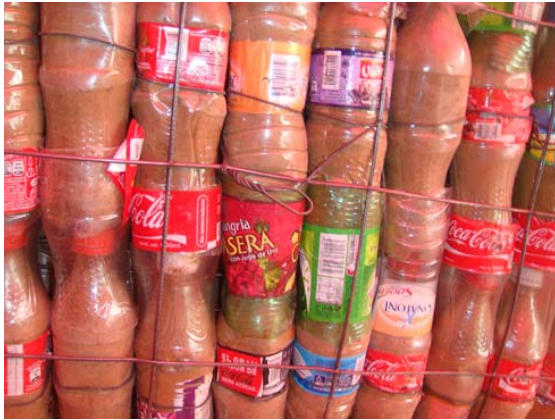
Figura 3.14 Amarres con alambre recocido
