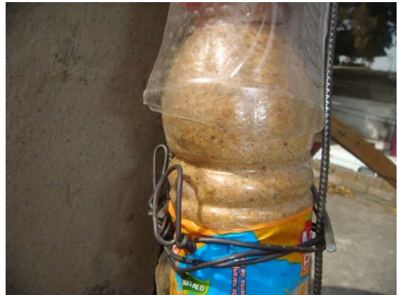
Figura 3.15 Detalle de Amarres con alambre recocido
