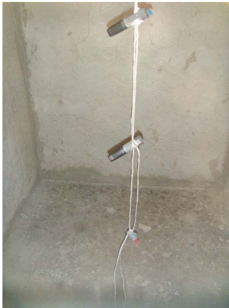
Figura 3.28 Colocación de los Data loggers internos en el prototipo.
