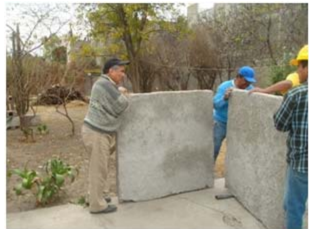
Figura 3.21 Colocación panel poniente.
