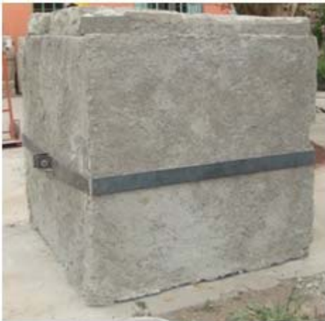
Figura 3.24 Colocación de techo y cinturón de acero.
