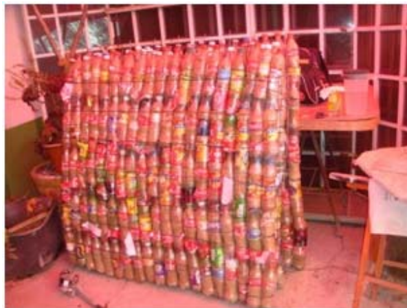
Figura 3.17 Paneles terminados listos para recibir aplanado.
