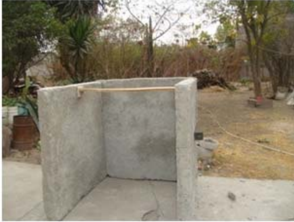
Figura 3.22 Colocación panel Oriente
