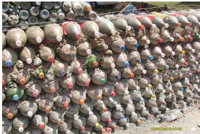
Figura 2.12 Muro de Casa construida con pet en Tlaxcala.
