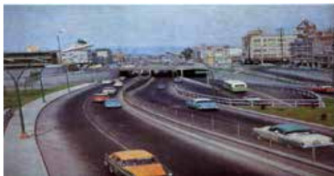
Figura 2. Viaducto Piedad y su cruce con avenida Revolución. Fuente: DDF, 1964: 138.
