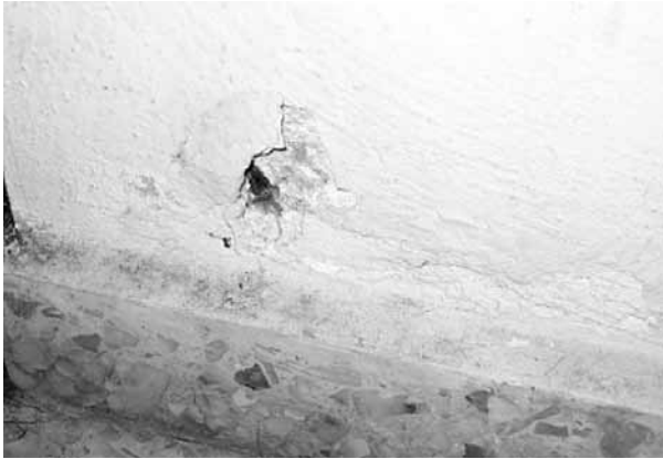
Figuras 18 y 19. Daño en cadena de cimentación por filtración de humedad y en cadena de cerramiento por corrosión.
