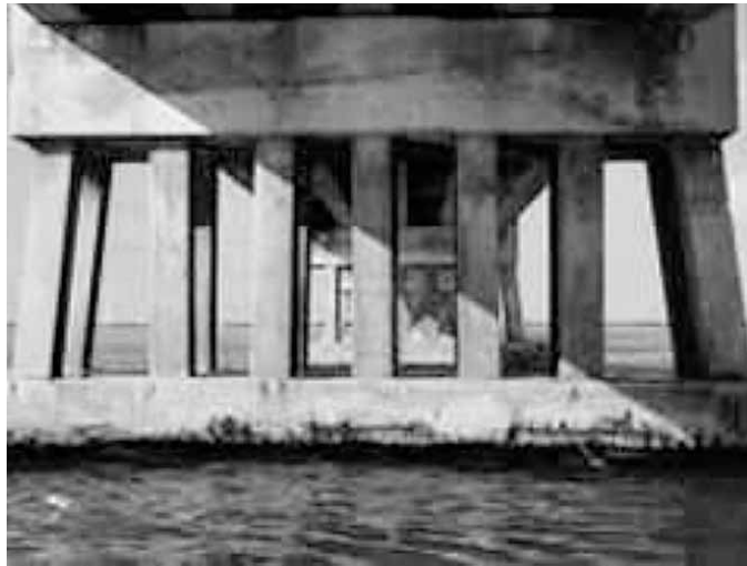
Figura 16. Aproximadamente 14 pilotes hincados en el lecho marino forman cada uno de los 108 caballetes.
