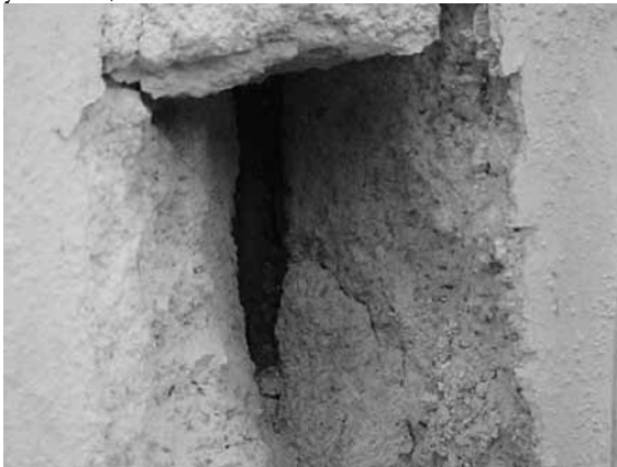
Figuras 20 y 21. Daño en losa y en castillo ahogado por corrosión de acero inducida por carbonatación.
