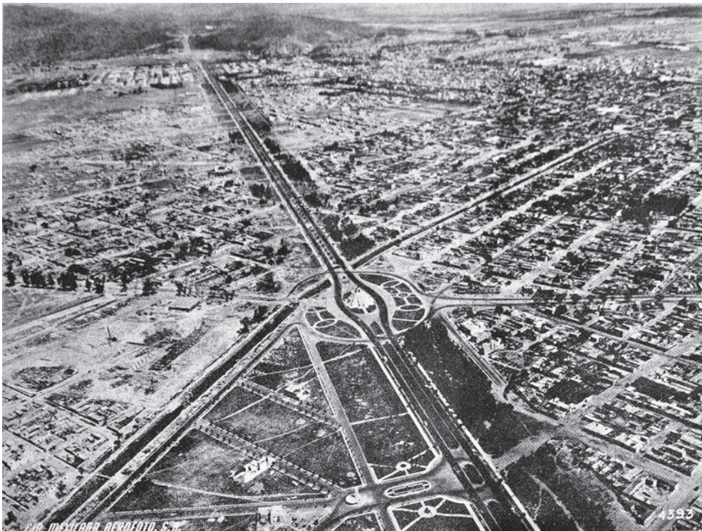
Figura 5. Perspectiva aérea, tomada sobre la carretera a México-Laredo, de sur a norte. Se aprecian las calzadas Jacarandas, de Suárez, Vallejo y Río del Consulado; en la intersección, el Monumento a la Raza. Fuente: En Gobierno del Distrito Federal. Sexenio, 1940-1946 . Reproducción fotográfica: Carlos Contreras de Oteyza.
