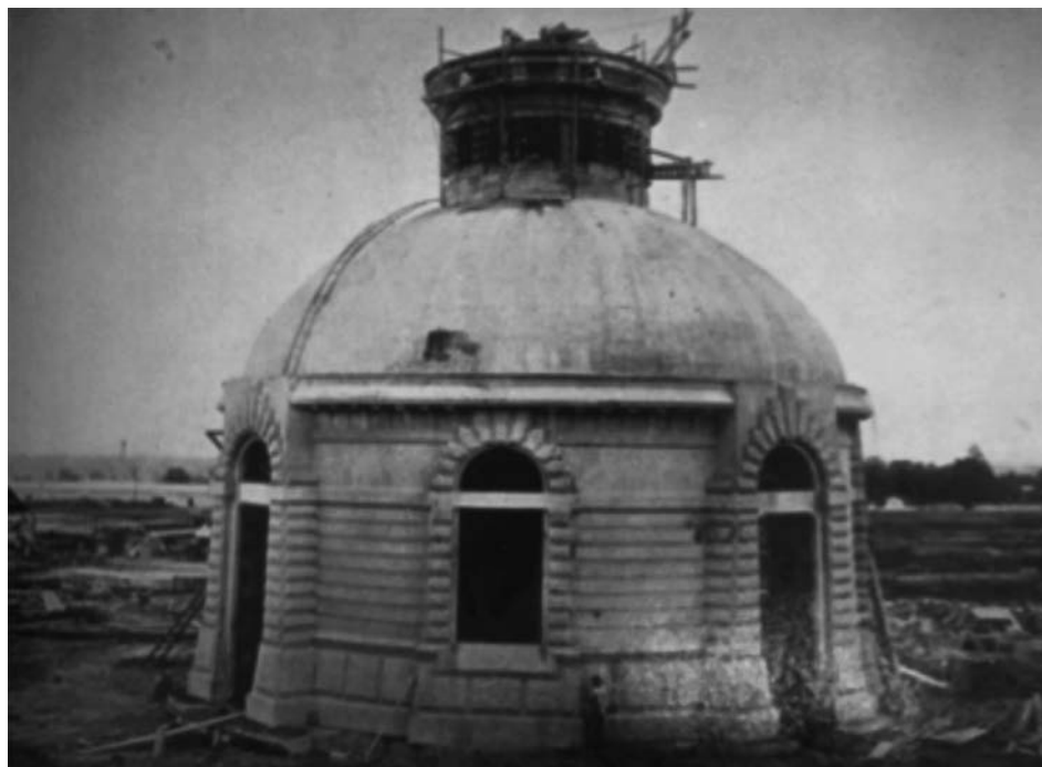
Figura 10. Cámara de las Válvulas en Chapultepec. Fuente: Marroquín, Memoria de las Obras para la Provisión de Aguas Potables de la Ciudad de México, 1914.
