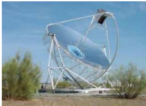
Figura 4 Típico Sistema Disco Stirling [4]
