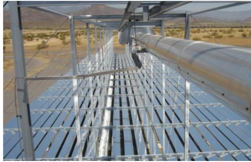
Figura 8 Sistema Fresnel lineal FRESDEMO (visto desde el receptor), en la Plataforma Solar de Almería, España
