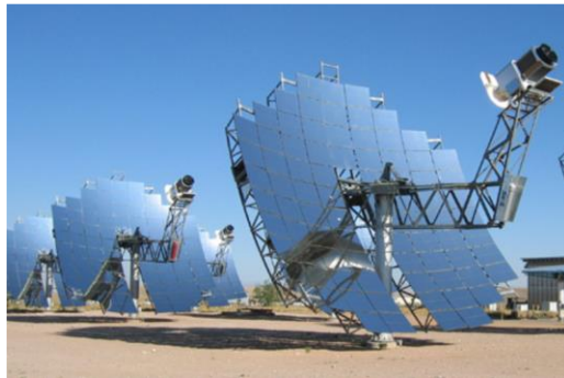
Figura 9 Sistemas de plato parabólico de la empresa Stirling Energy Systems.
