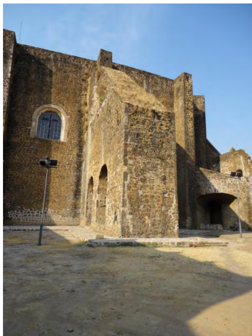
Figura 304. Tlayacapan, Mor. Ex convento San Juan Bautista. Muro y contrafuerte de la epístola. TMH 2017 (imagen anterior al sismo)
