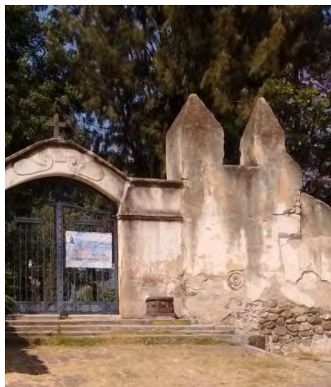
Figura 285. Totolapan, Mor. Ex convento San Guillermo. Arco de acceso al atrio. TMH 2019
