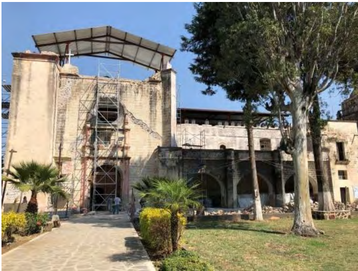
Figura 290. Totolapan, Mor. Ex convento San Guillermo. Daños al templo. Colapso de torre campanario y remate en fachada. Proceso de los trabajos de intervención. TMH 2019
