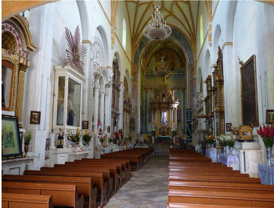
Figura 154. Tochimilco, Pue. Templo La Asunción. Nave y ábside cubiertos con bóveda de nervaduras. Consulta septiembre del 2019 https://paseopormexico.com/lugares/1225/
