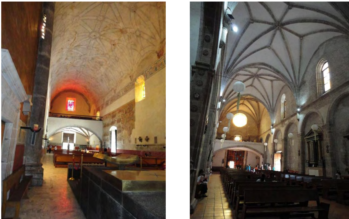
Figura 143. Izquierda: Cuernavaca, Mor. La Catedral La Asunción, presenta la nave rasa en nave. Derecha: Oaxtepec, Mor. Templo Santo Domingo de Guzmán. Nave y coro cubiertos con bóveda de nervaduras, con interrupciones. Vistas hacia el coro y sotocoro. TMH 2011 y 2017, respectivamente.
