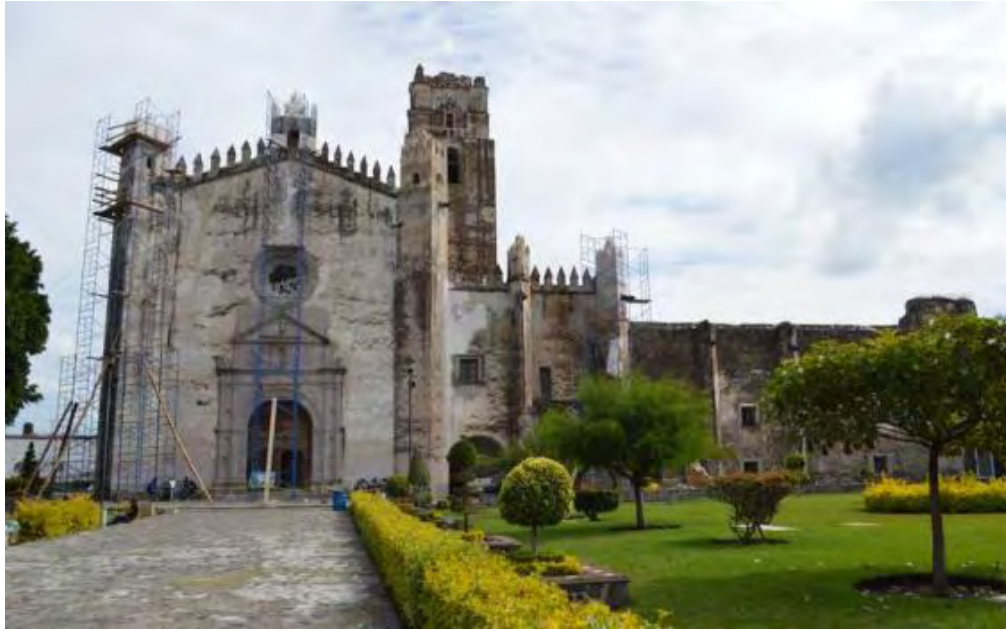
Figura 340. Yecapixtla, Mor. Ex convento San Juan Bautista. Templo. Proceso de trabajos de intervención después del sismo del 19 de septiembre del 2017. Consulta 20 nov 2019 https://www.elsoldecuernavaca.com.mx/local/-2754653.html
