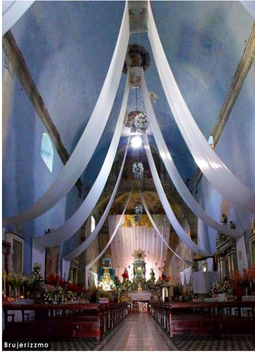
Figura 144. Izquierda: Atlatlahucan, Mor. Templo San Mateo Apóstol. Interior del templo, vista hacia el presbiterio. Cubierta bóveda de cañón corrido, sin interrupciones. Tlayacapan, Mor. Templo San Juan Bautista. Interior cubierto con bóveda de cañón corrido, con interrupciones, arcos de medio punto apoyados en pilastras. TMH mayo del 2017
