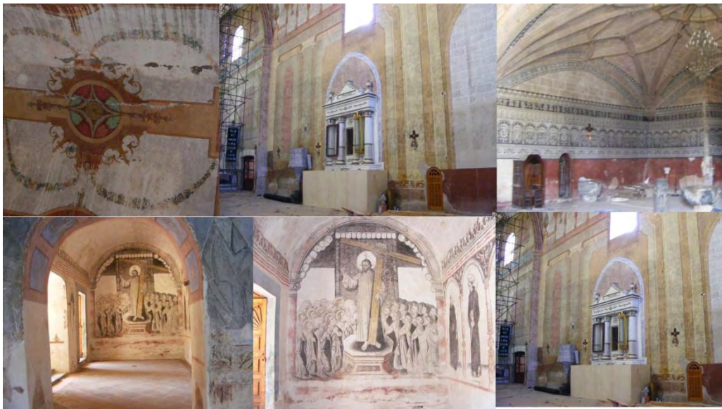
Figura 344. Yecapixtla, Mor. Ex convento San Juan Bautista. Templo, interior. Trabajos de inyección en grietas y consolidación de acabados. Consulta 26 de noviembre del 2019 https://www.elsoldecuernavaca.com.mx/local/estara-listo-san-juan-en-10-meses-1927290.html
