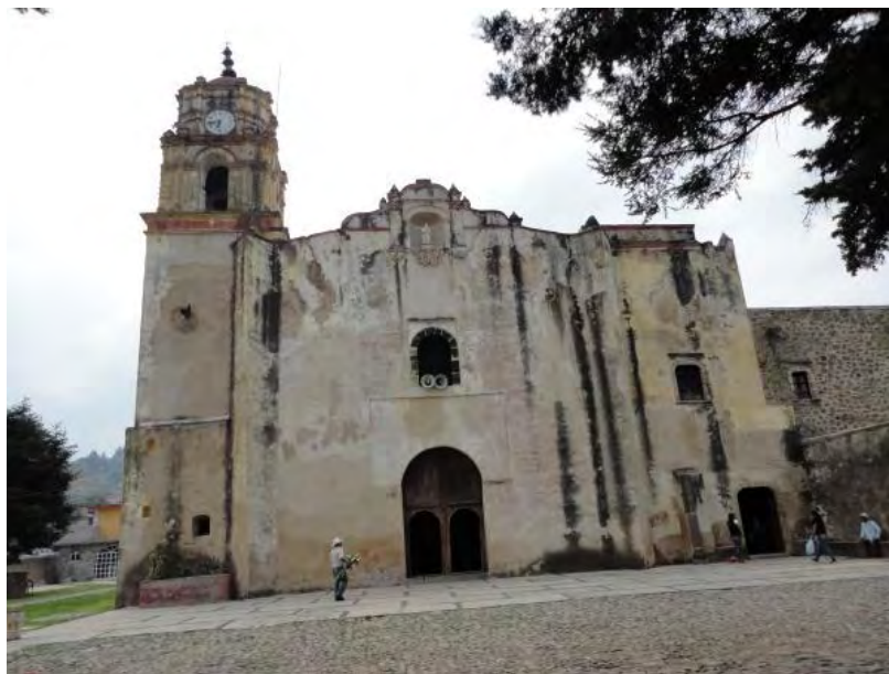
Figura 252. Tetela del Volcán, Mor. Ex convento San Juan Bautista. Templo. Fachada principal. TMH mayo 2017
