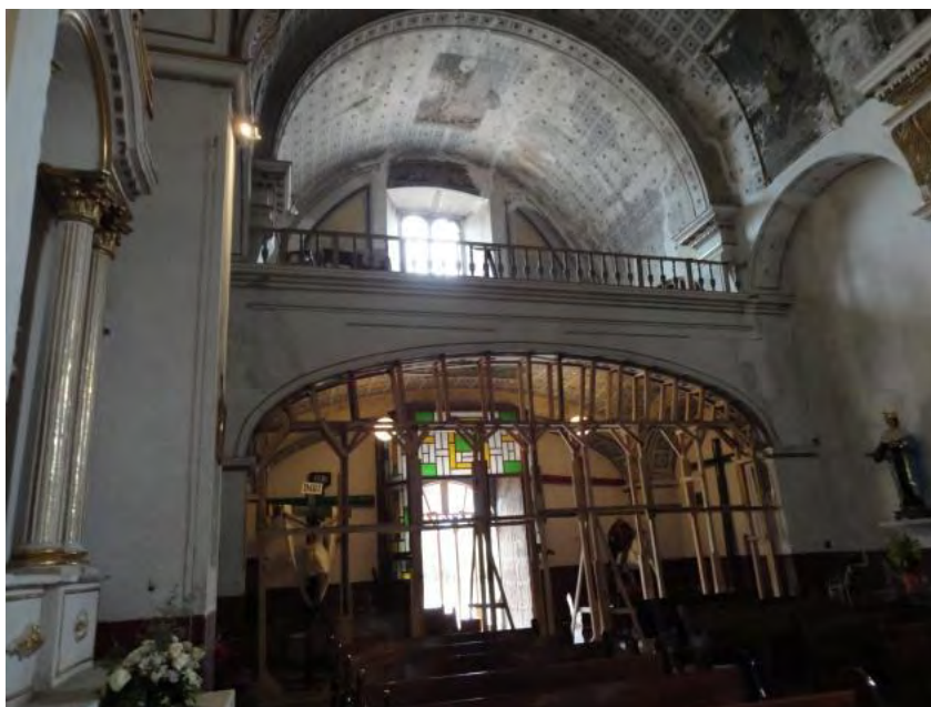
Figura 403. San Andrés Calpan, Puebla. Ex convento de San Francisco de Asís. Estructura provisional para contener arco bajo el coro. TMH 2017
