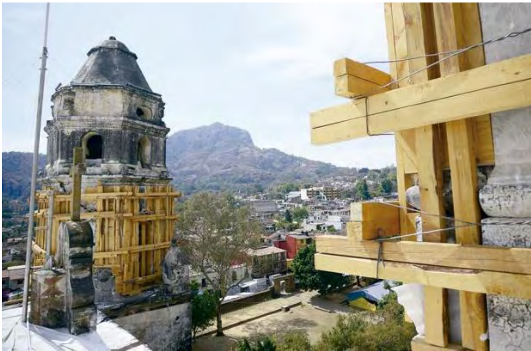
Figura 283. Tepoztlán, Mor. Ex convento Nuestra Señora de La Natividad. Torre de campanario. Proceso de intervención; apuntalamiento en los cuerpos de la torre. Consultado en marzo del 2019 https://interactivo.eluniversal.com.mx/2019/patrimonio-sismos/
