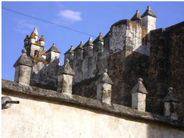
Figura 142. Tepoztlán, Mor. Templo y ex convento La Natividad. Coronamiento de los muros con almenas. TMH 2010
