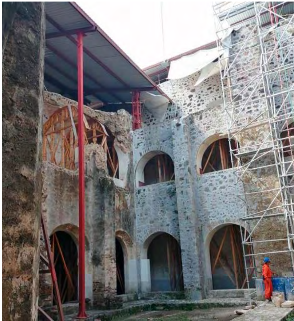
Figura 296. Totolapan, Mor. Ex convento San Guillermo. Claustro. Proceso de trabajos de intervención en muros y contrafuertes, integración y consolidación de materiales. Consulta 20 de noviembre del 2019 https://www.lajornadamorelos.com.mx/municipios/2019/09/18/14061?page=1
