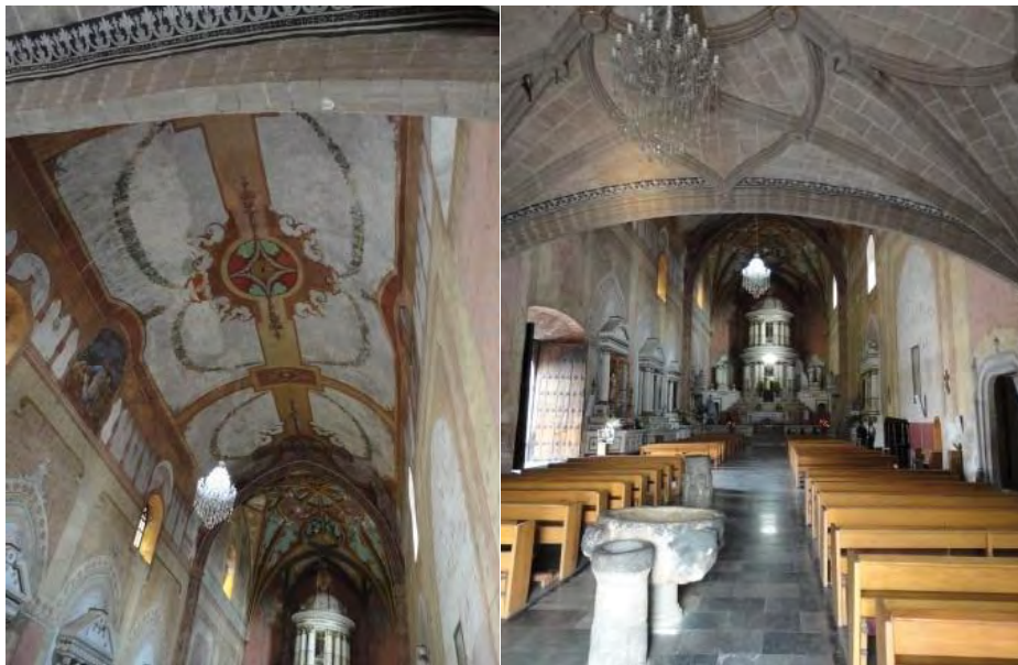
Figura 147. Yecapixtla, Mor. Templo San Juan Bautista. Nave cubierta con bóveda de cañón corrido. Presbiterio y sotocoro con bóveda de nervaduras. TMH mayo del 2017
