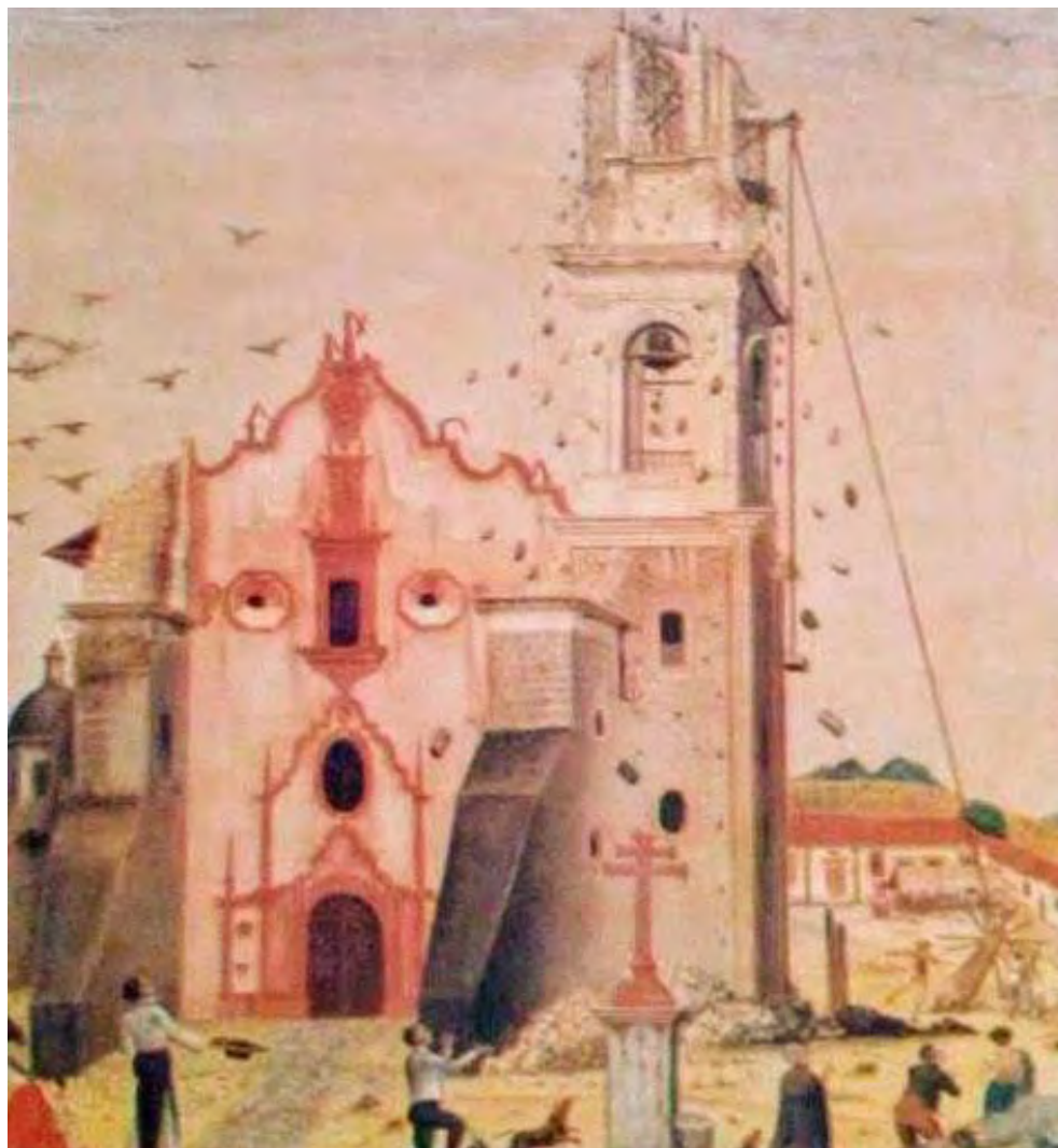
Figura 261. Catedral de Pátzcuaro en 1845. Se describe el campanario en construcción en 1840 colapsando en el sismo del 19 de junio de 1845. Pintura que se encuentra en el Museo de Morelia. Ex voto relacionado con el sismo. Anónimo. McAndrew, 1965, p. 649 y V. García & Suárez, G. 1996, portada.
