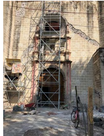
Figura 290. Totolapan, Mor. Ex convento San Guillermo. Daños al templo. Colapso de torre campanario y remate en fachada. Proceso de los trabajos de intervención. TMH 2019
