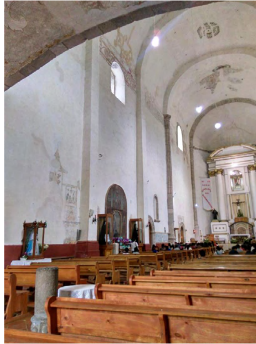
Figura 144. Izquierda: Atlatlahucan, Mor. Templo San Mateo Apóstol. Interior del templo, vista hacia el presbiterio. Cubierta bóveda de cañón corrido, sin interrupciones. Tlayacapan, Mor. Templo San Juan Bautista. Interior cubierto con bóveda de cañón corrido, con interrupciones, arcos de medio punto apoyados en pilastras. TMH mayo del 2017
