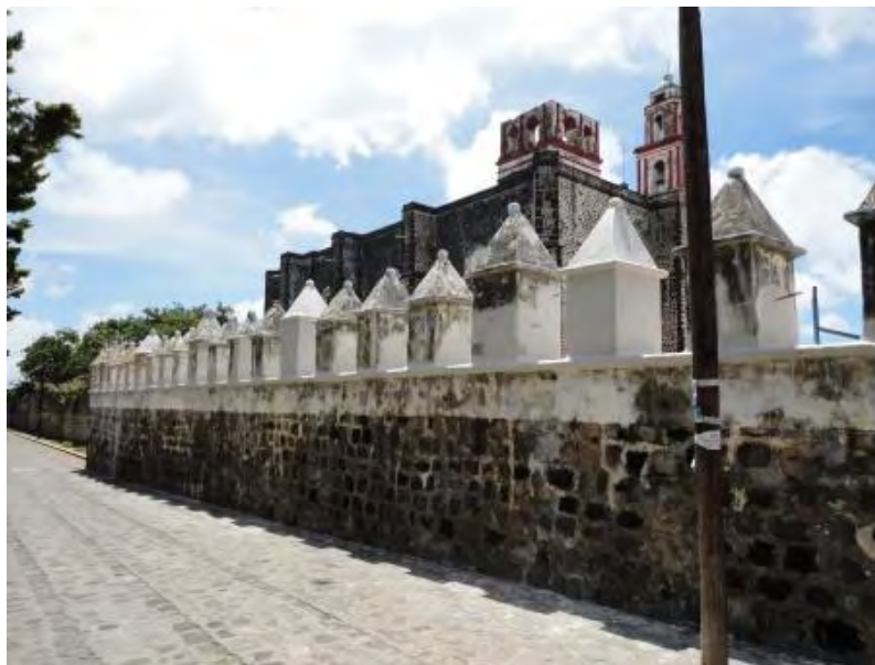
Figura 386. Tochimilco, Puebla. Ex convento Nuestra Señora de la Asunción. Ubicación del conjunto conventual con respecto a la plaza central y fuente, lugar de abastecimiento de agua al convento. Barda atrial con almenas. TMH 2018
