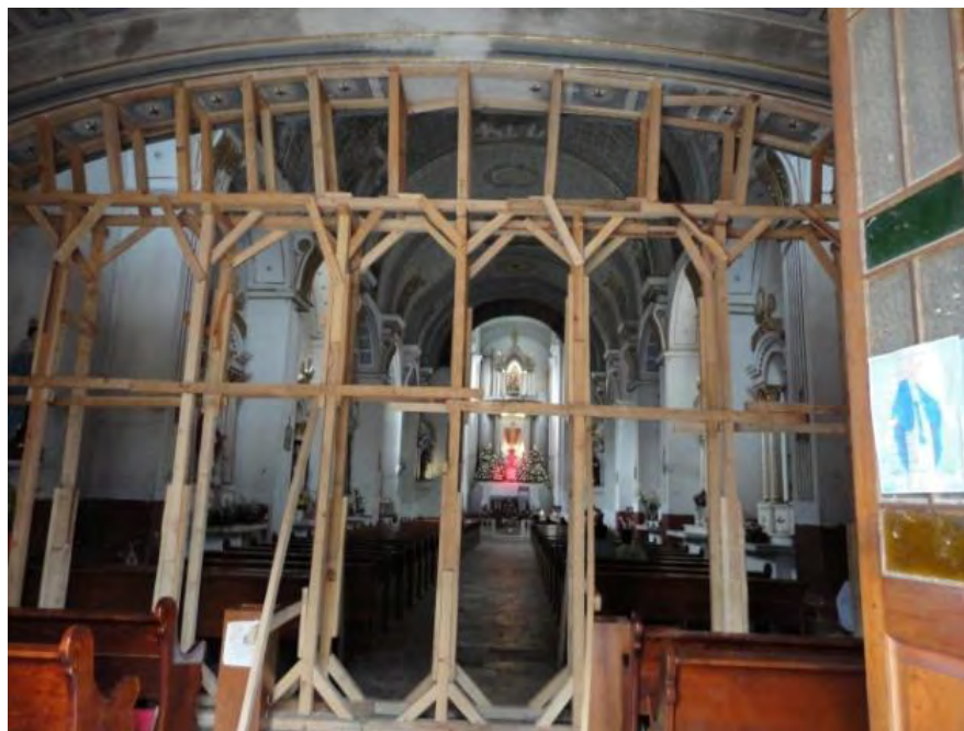
Figura 402. San Andrés Calpan, Puebla. Ex convento de San Francisco de Asís. Estructura provisional para contener arco bajo el coro. TMH 2017
