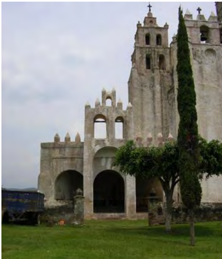
Figura 239. Atlatlahucan, Mor. Ex convento San Mateo Apóstol. Atrio. Capilla abierta. TMH 2004
