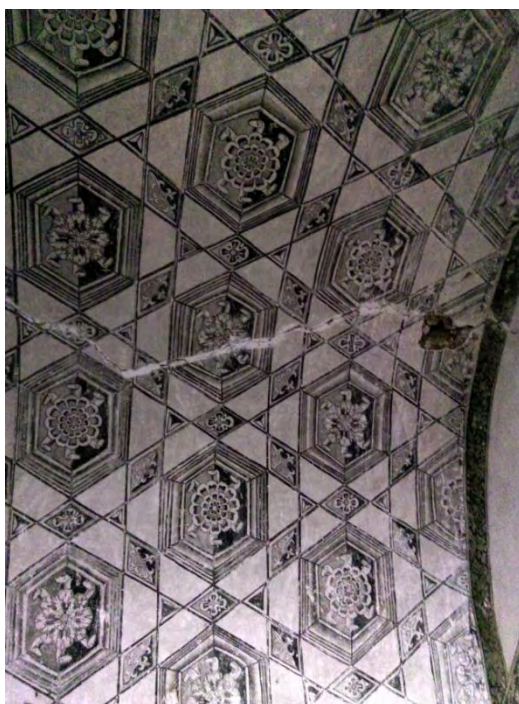
Figuras 228. Tlayacapan Mor. Ex convento San Juan Bautista. Capilla abierta y portería. Desprendimiento de aplanados y de pintura mural. TMH mayo 2017
