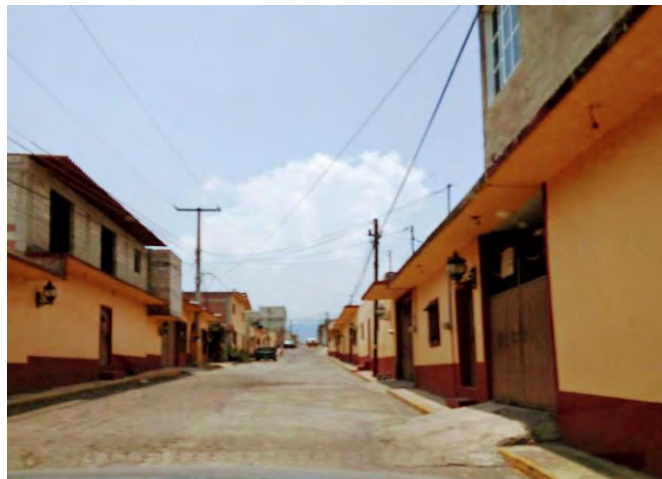
Figura 86. Atlatlahucan, Mor. Calle cercana al conjunto conventual. TMH junio del 2019
