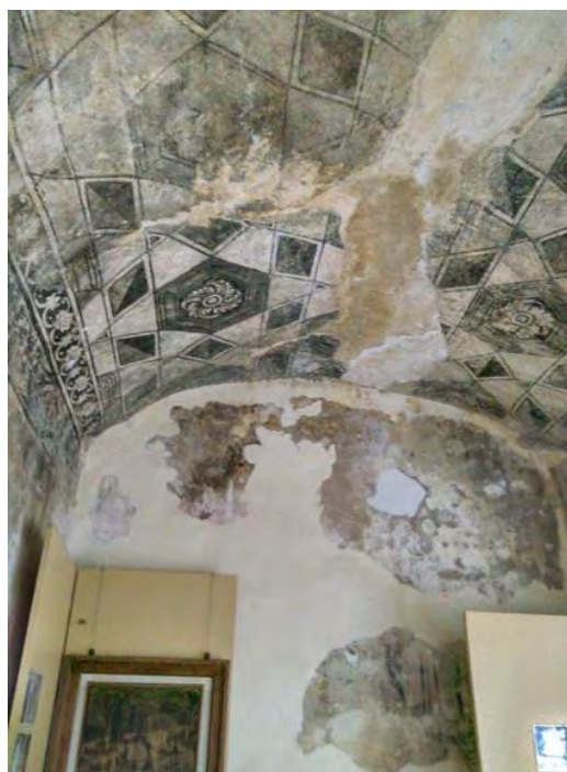
Figuras 228. Tlayacapan Mor. Ex convento San Juan Bautista. Capilla abierta y portería. Desprendimiento de aplanados y de pintura mural. TMH mayo 2017
