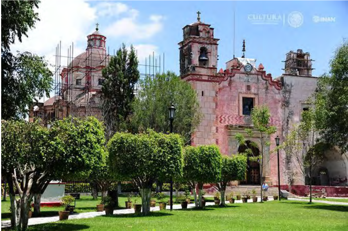
Figura 381. Zacualpan de Amilpas, Mor. Ex convento de la Inmaculada Concepción. En proceso de trabajos de rehabilitación en templo. Consulta 28 de noviembre del 2019 https://restauracionpatrimonio.cultura.gob.mx/multimedia/detalle/214
