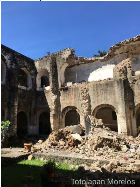
Figuras 294 y 295. Totolapan, Mor. Ex convento San Guillermo. Claustro. Colapso de bóveda, contrafuerte y muros en deambulatorio alto. Consultado 20 noviembre 2019 www.launion.com
