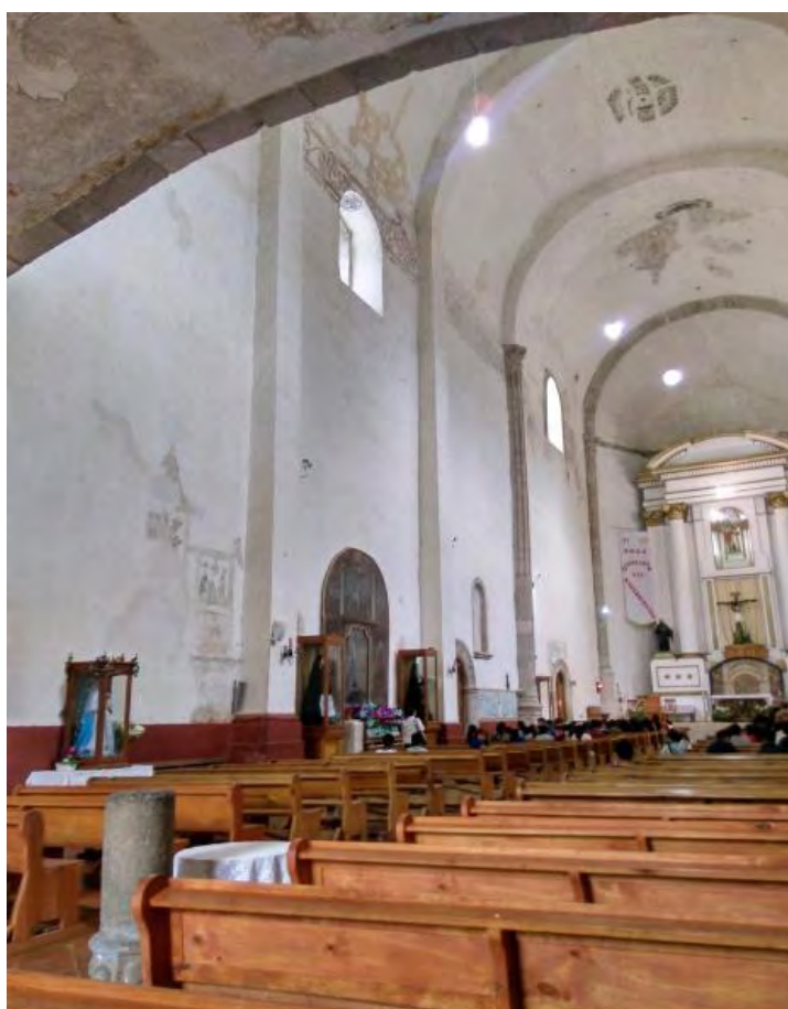
Figura 222. Tlayacapan, Morelos. Ex convento San Juan Bautista. Interior del templo. TMH mayo 2017
