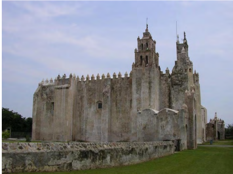
Figura 245. Atlatlahucan, Mor. Ex convento San Mateo Apóstol. Fachada norte del templo. Contrafuertes en presbiterio, nave del templo y torre-campanario, coronamiento de los muros con almenas. TMH 2004
