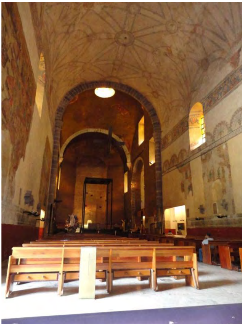
Figura 208. Cuernavaca, Mor. Catedral La Asunción de María. Interior del templo. Nave con bóveda de cañón corrido. TMH 2011
