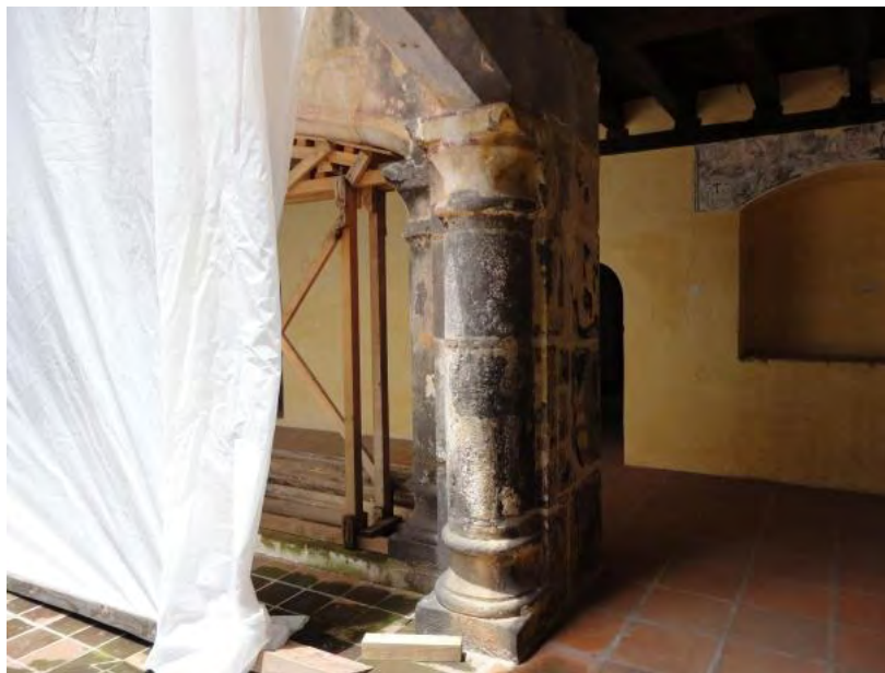
Figura 391. Tochimilco, Puebla. Ex convento Nuestra Señora de la Asunción. Claustro bajo. Deambulatorio. Pilar con pilastras. Trabajo de intervención en proceso. TMH 2018
