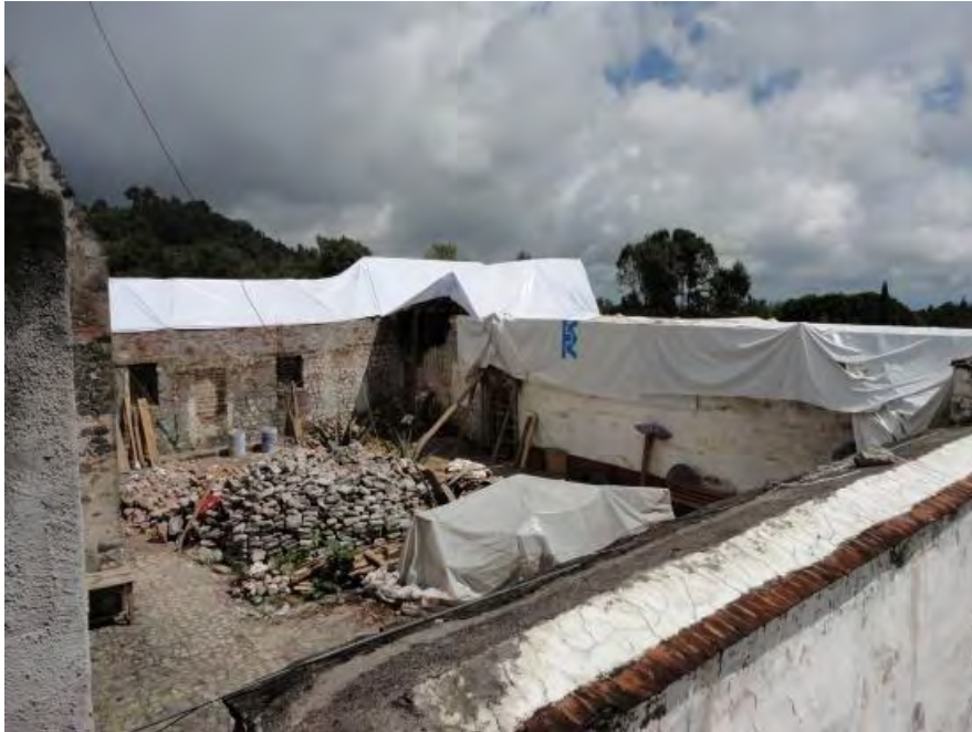
Figura 376. Hueyapan, Mor. Ex convento Santo Domingo de Guzmán. Conjunto conventual en proceso de rehabilitación, vista desde torre campanario. TMH 2019
