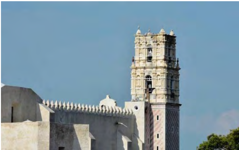
Figura 275. Cuernavaca, Mor. Ex convento La Asunción, hoy Cuernavaca. Templo y torre. Trabajos de intervención en fachada norte y campanario. Consulta 23 de noviembre del 2019 https://www.elsoldecuernavaca.com.mx/local/especial-continua-la-restauracion-de-inmuebles-historicos-4198838.html
