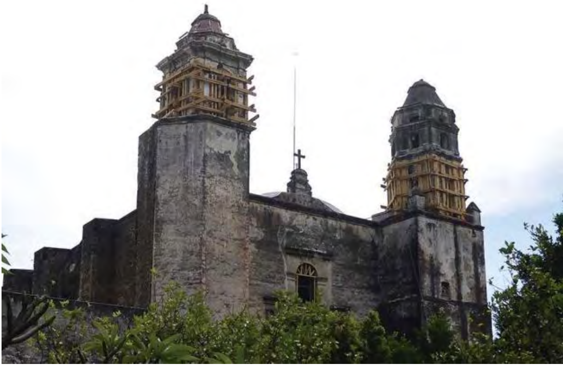
Figura 282. Tepoztlán, Mor. Ex convento Nuestra Señora de La Natividad. Torre de campanario. Proceso de intervención; apuntalamiento en los cuerpos de la torre. Consultado en marzo del 2019 https://interactivo.eluniversal.com.mx/2019/patrimonio-sismos/
