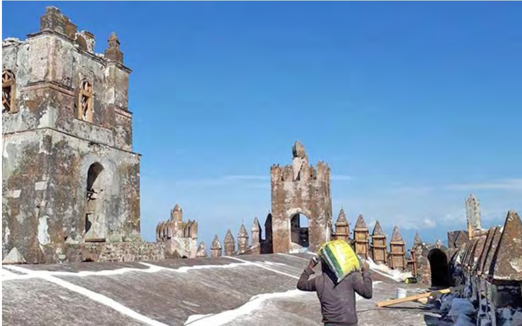
Figura 349. Yecapixtla, Mor. Ex convento San Juan Bautista Exterior del templo. Trabajos de intervención en azotea. Consulta 26 de noviembre del 2019 https://www.elsoldecuernavaca.com.mx/local/estara-listo-san-juan-en-10-meses-1927290.html
