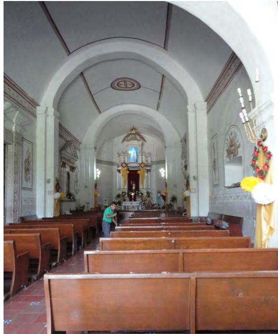
Figura 146. Zacualpan de Amilpas, Mor. Interior del templo. Cubierto con bóveda de cañón corrido, dividido en tramos y apoyado en pilastras. TMH mayo 2017
