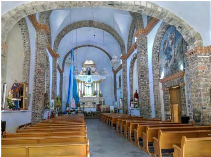
Figura 145. Totolapan, Mor. Templo San Guillermo. Interior del templo. Cubierto con bóveda de arista con lunetos. Mayo del 2017
