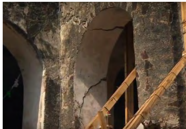
Figuras 294 y 295. Totolapan, Mor. Ex convento San Guillermo. Claustro. Colapso de bóveda, contrafuerte y muros en deambulatorio alto. Consultado 20 noviembre 2019 www.launion.com
