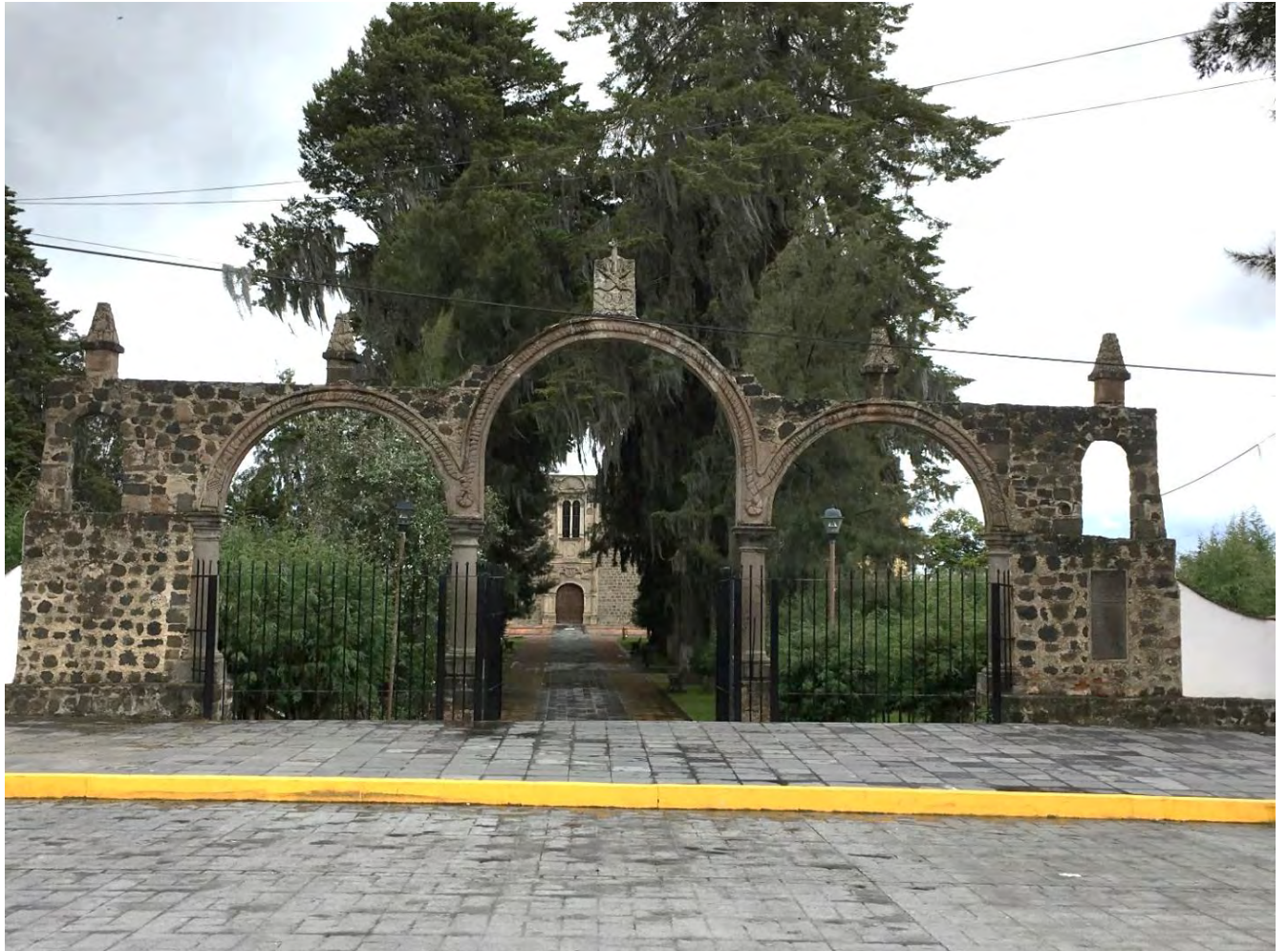
Figura 400. San Andrés Calpan, Puebla. Ex convento de San Francisco de Asís. Arcada real. TMH 2017
