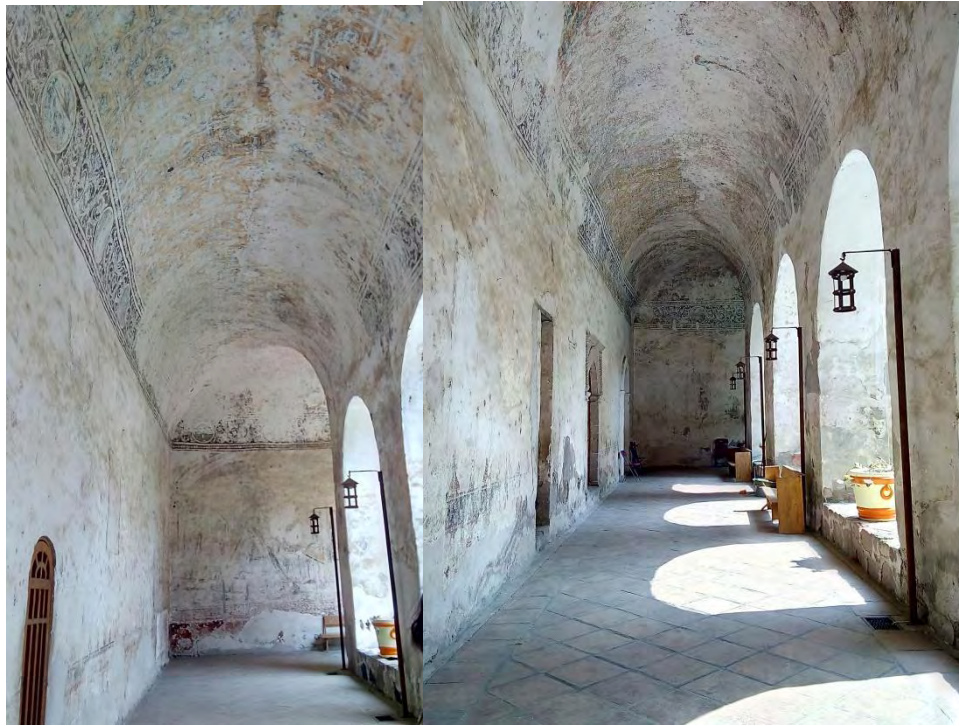
Figura. 353. Yecapixtla, Mor. Ex convento San Juan Bautista. Claustro. Deambulatorio. TMH 2019
