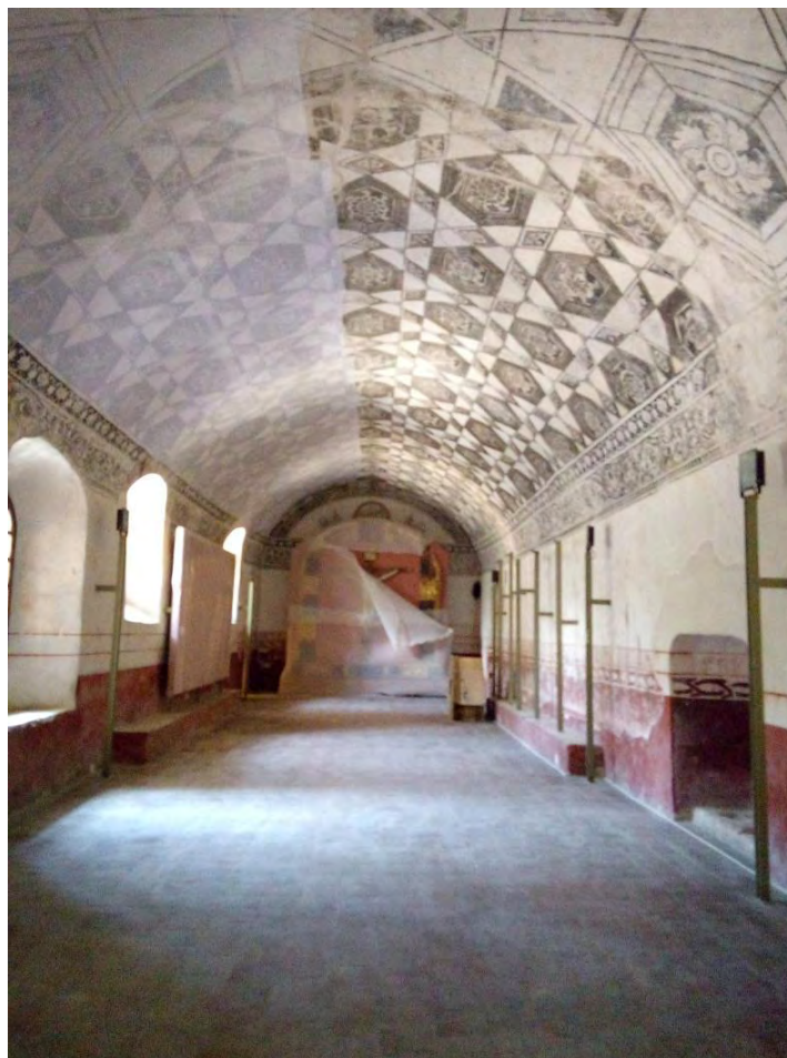
Figura 237. Tlayacapan, Mor. Ex convento San Juan Bautista. Refectorio. Estado de conservación, durante los trabajos de intervención después del sismo del 19 de septiembre del 2017. TMH 2019
