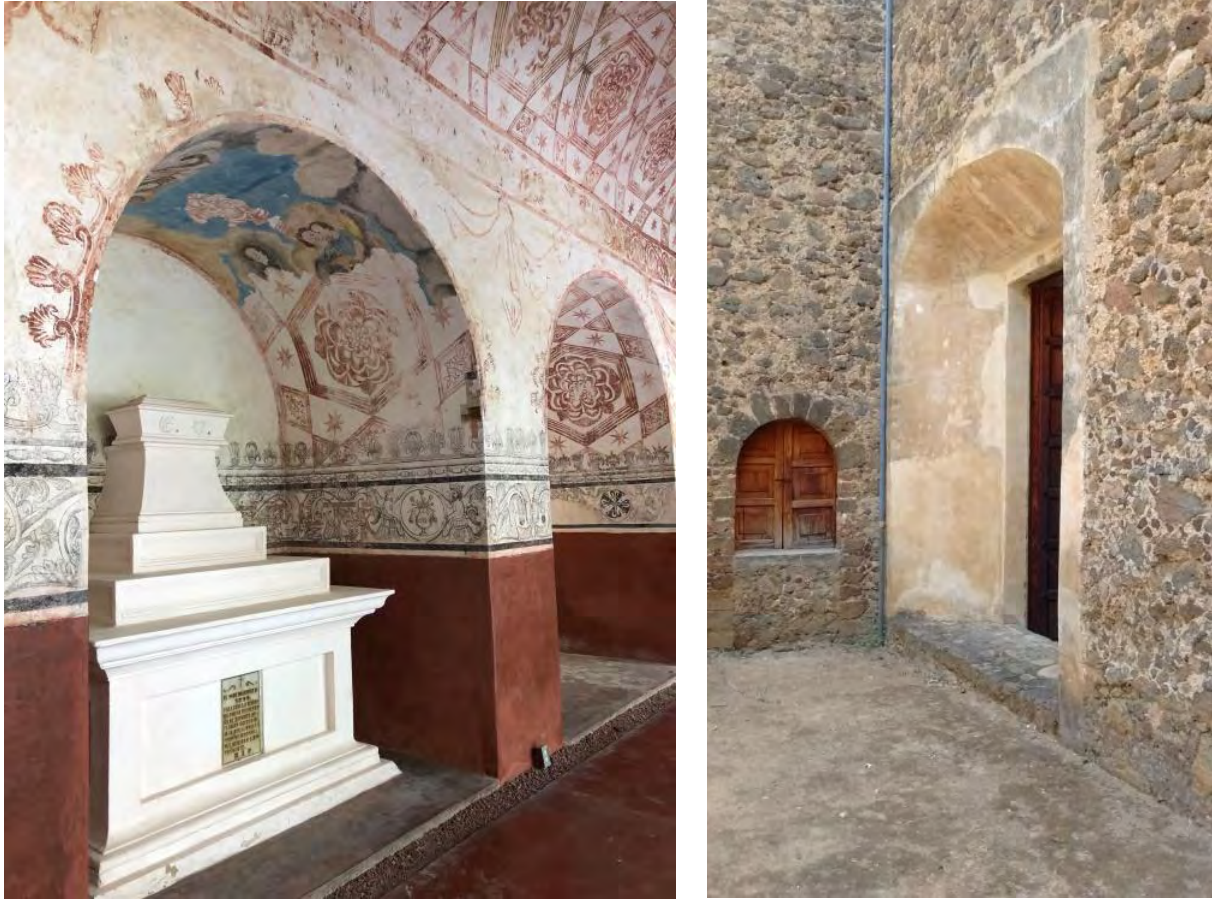
Figura 219. Tepoztlán, Mor. Ex convento Nuestra Señora de La Natividad. Claustro alto, pasillo. Pintura mural que cubre todos los espacios. Materiales utilizados en la construcción del edificio. TMH 2019
