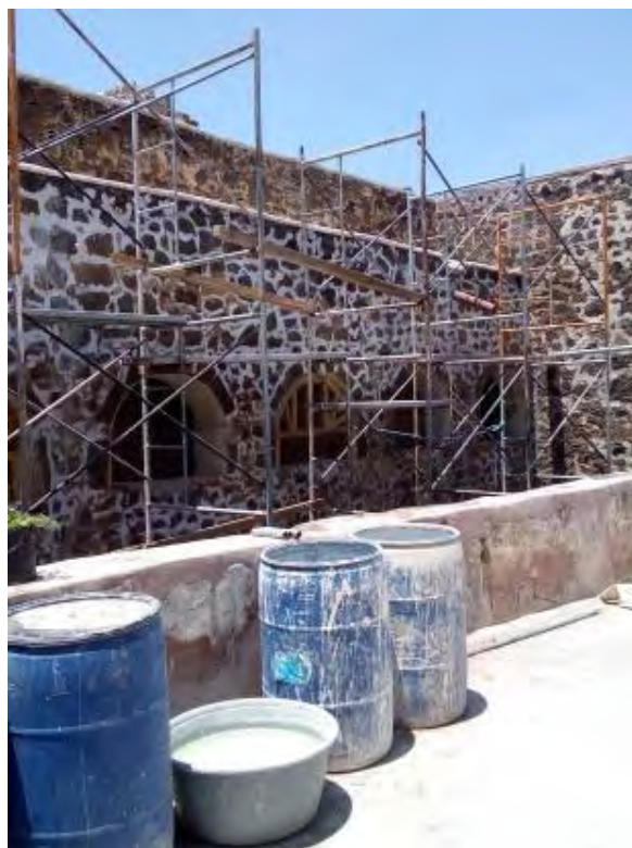
Figura 313. Tlayacapan, Mor. Ex convento San Juan Bautista. Claustro alto. Trabajos de consolidación en área de celdas. TMH 2019
