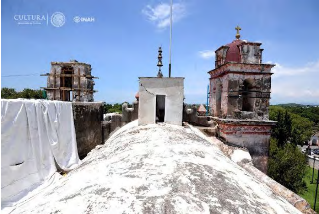
Figura 384. Zacualpan de Amilpas, Mor. Ex convento de la Inmaculada Concepción. Trabajos de consolidación en la cubierta de la nave del templo y campanario. Consulta 28 de noviembre del 2019 https://restauracionpatrimonio.cultura.gob.mx/multimedia/detalle/214
