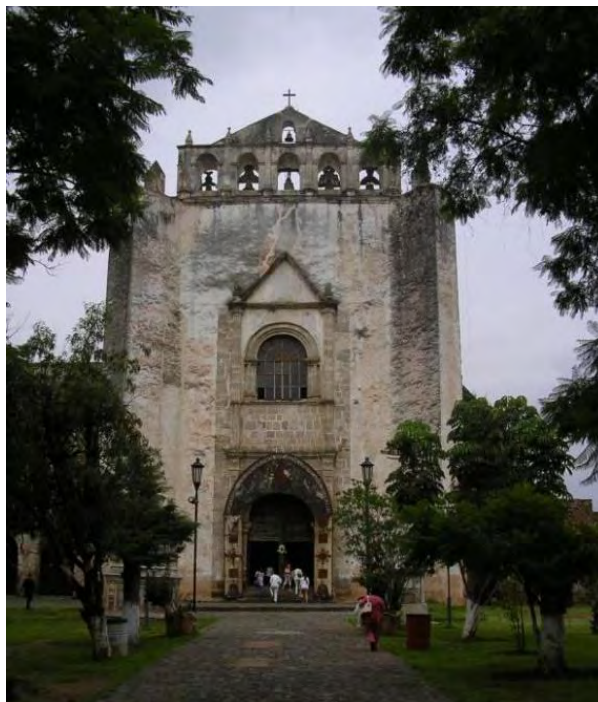
Figuras 221. Tlayacapan, Mor. Ex convento San Juan Bautista. Templo, fachada principal: Contrafuertes laterales, acceso al centro, ventana de coro. Detalle de acceso al interior y ventana del coro. 2008 y 2017 respectivamente.
