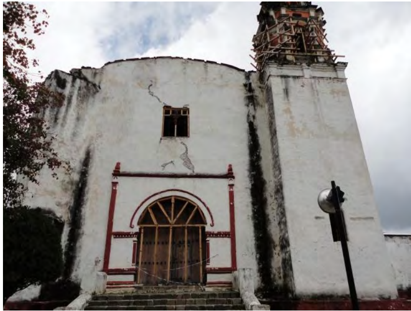
Figura 378. Hueyapan, Mor. Ex convento Santo Domingo de Guzmán. Fachada de templo. Trabajos de intervención en torre campanario y muro de fachada. TMH 2019
