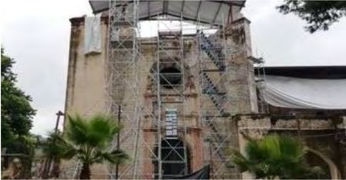
Figura 291. Totolapan, Mor. Ex convento San Guillermo. Templo. Trabajos de intervención. Consulta 20 de noviembre del 2019 http://elporvenir.mx/?content=noticia&id=169064
