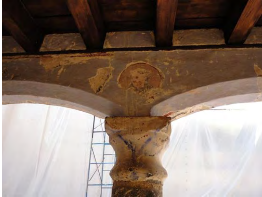
Figura 392. Tochimilco, Puebla. Ex convento Nuestra Señora de la Asunción. Claustro bajo. Deambulatorio. Apoyo de arcos en capiteles de columnas. TMH 2018
