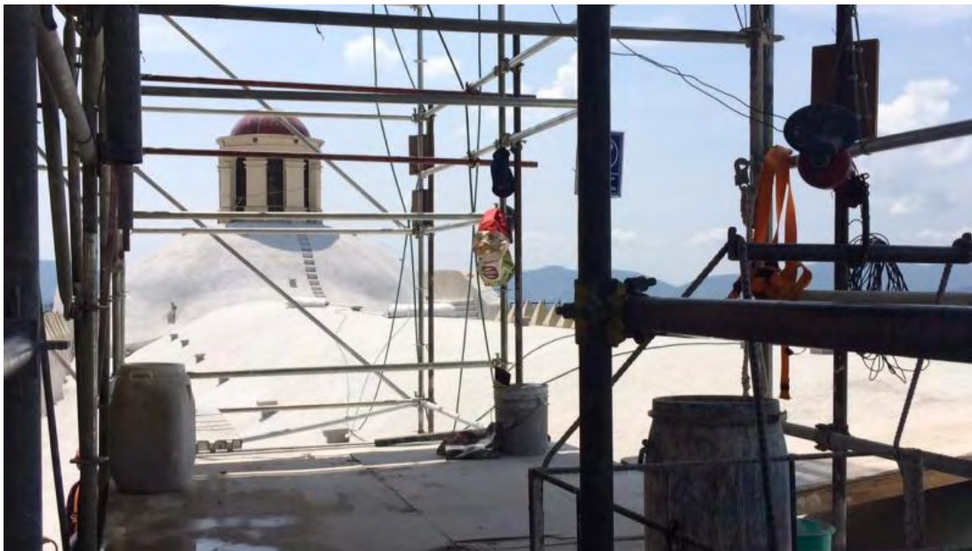
Figuras 273. Cuernavaca, Mor. Ex convento La Asunción, hoy Catedral. Templo, cubierta y almenas que coronan los muros. Trabajos de rehabilitación, consolidación e impermeabilización. Consulta 20 noviembre del 2019 https://www.google.com/search?q=catedral+de+cuernavaca+restauracion&tbm=isch&ved=2ahUK
