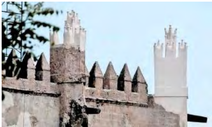
Figura 347. Yecapixtla, Mor. Ex convento San Juan Bautista Exterior del templo. Trabajos de intervención en garitones y almenas: consolidación e integración de aplanados a la cal. Consulta 26 noviembre 2019 https://www.elsoldecuernavaca.com.mx/local/estara-listo-san-juan-en-10-meses-1927290.html
