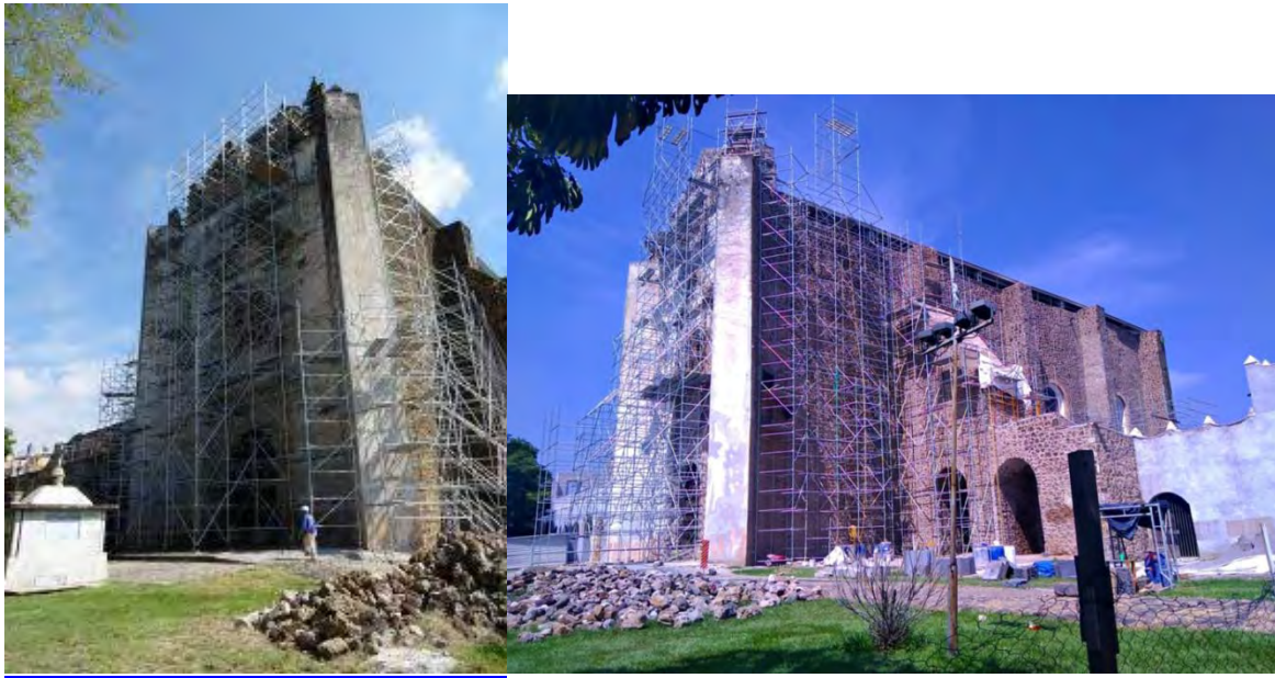
Figura 308. Tlayacapan, Mor. Ex convento San Juan Bautista. Fachada del templo. Preparación para los trabajos de intervención. Consulta 22 de noviembre del 2019 http://campaners.com/php/fotos_campanar.php?numer=9287
