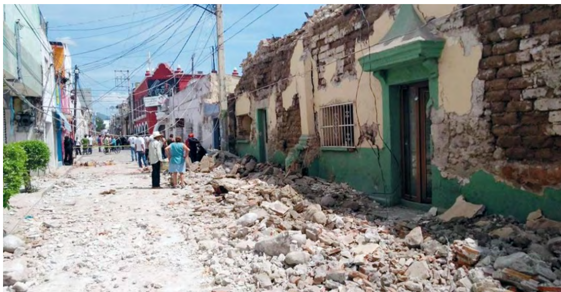
Figura 267. Jojutla de Juárez, Mor. Efectos del sismo en las construcciones. Consultado el 6 de diciembre del 2019 https://noticias.canal22.org.mx/2017/09/23/danos-en-jojutla-morelos-epicentro-del-sismo/
