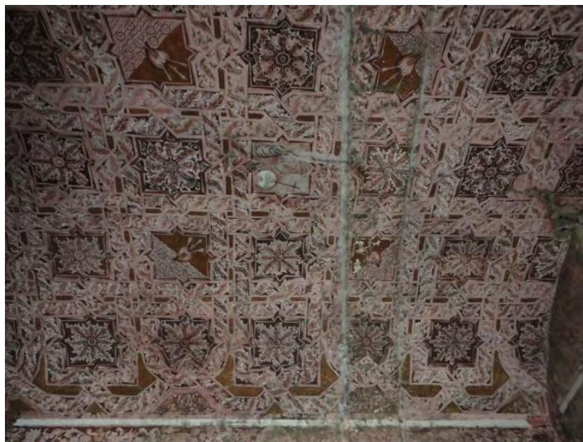
Figura 248. Atlatlahucan, Mor. Ex convento San Mateo Apóstol. Sacristía. Cubierta de cañón corrido y con pintura mural con lacerías, combinando elementos geométricos y algunos símbolos agustinos. TMH mayo 2017
