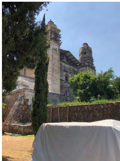
Figura 284 (1-6). Tepoztlán, Mor. Ex convento Nuestra Señora de La Natividad. 1. Proceso de trabajos de intervención: apuntalamiento de torre campanario; 2. Consolidación de materiales e integración de recubrimiento en remates de muros del templo. 3 y 4 Trabajos de consolidación y limpieza en fachada del templo. 6. Colocación de cubierta en bóveda del templo para protección de trabajos de intervención. TMH 2019
