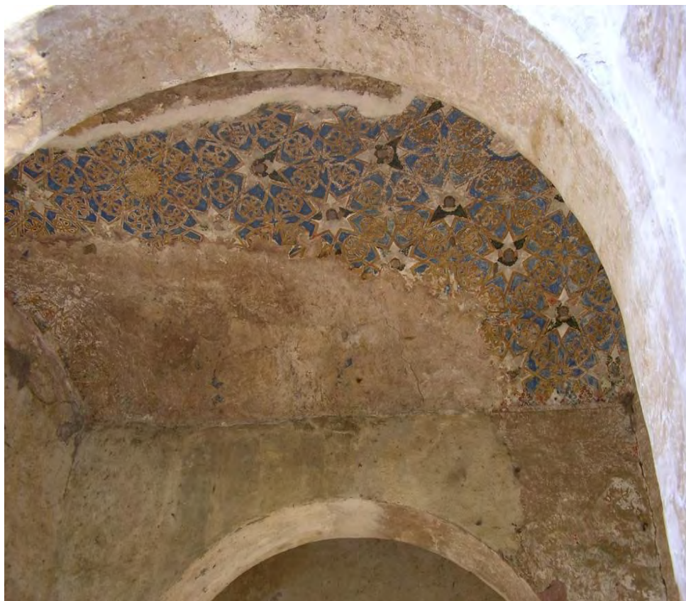
Figura 249. Atlatlahucan, Mor. Ex convento San Mateo Apóstol. Capilla abierta. Interior, pintura mural en bóveda. TMH 2011
