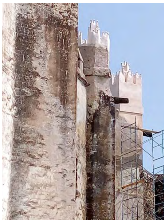
Figuras 345 y 346. Yecapixtla, Mor. Ex convento San Juan Bautista Exterior del templo. Trabajos de intervención en garitones y almenas: consolidación e integración de aplanados a la cal. TMH 2019
