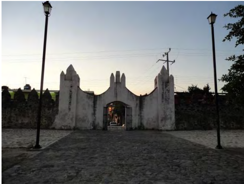
Figura 338. Yecapixtla, Mor. Ex convento San Juan Bautista. Arco de Acceso principal. TMH 2010
