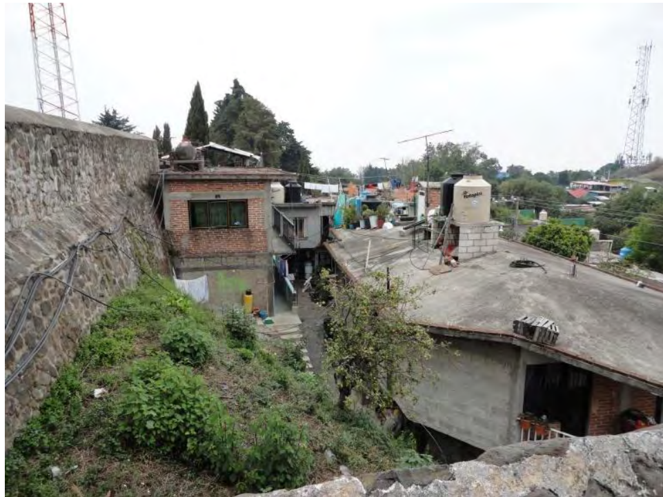
Figura 203. Tetela del Volcán, Mor. Ex convento San Juan Bautista. Vista aérea, invasiones al terreno original del conjunto conventual. TMH mayo 2017
