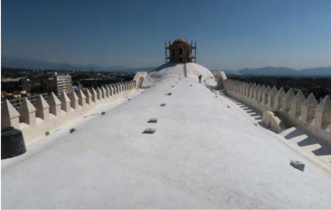
Figuras 274. Cuernavaca, Mor. Ex convento La Asunción, hoy Catedral. Templo, cubierta y almenas que coronan los muros. Trabajos de rehabilitación, consolidación e impermeabilización. Consulta 20 noviembre del 2019 https://www.google.com/search?q=catedral+de+cuernavaca+restauracion&tbm=isch&ved=2ahUK
