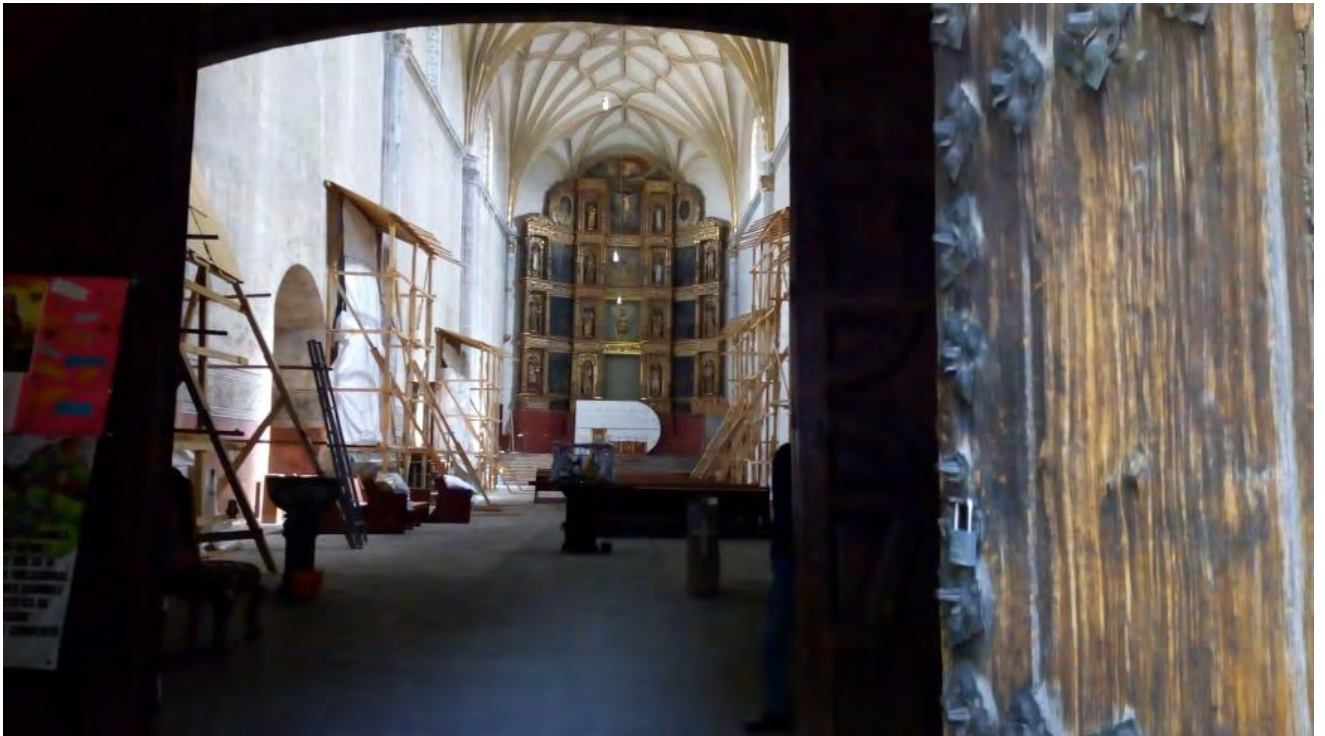
Figura 405. Huejotzingo, Pue. Ex convento San Miguel Arcángel. Interior del templo. Nave y presbiterio. Apuntalamiento de muros. En espera de ser intervenido. Consulta 20 de noviembre del 2019 http://municipiospuebla.mx/nota/2019-06-16/huejotzingo/exigen-informe-de-restauraci%C3%B3n-del-ex-convento-en-huejotzingo
