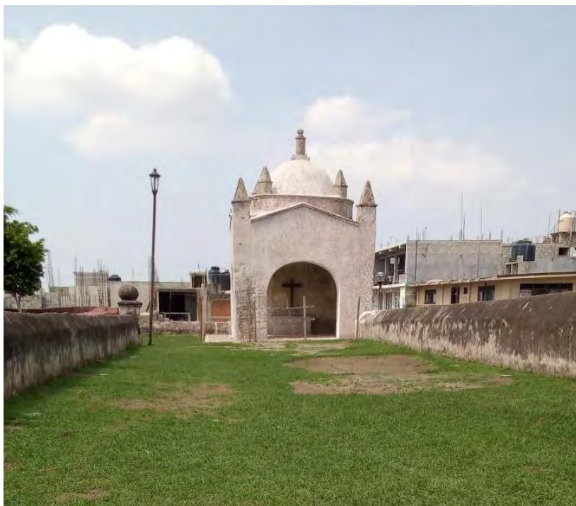
Figura 328. Atlalahucan, Mor. Ex convento San Mateo Apóstol. Capilla posa. Trabajo de rehabilitación terminado. TMH 2019
