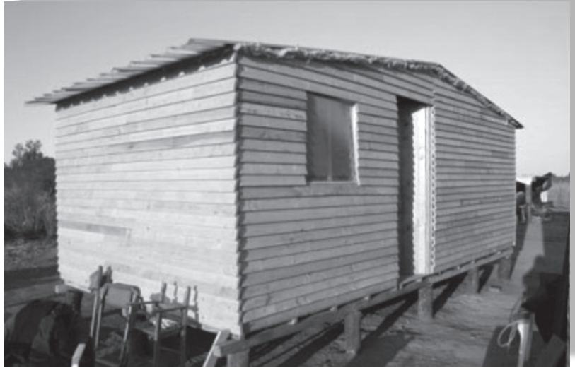
Imagen 7: Modelo de vivienda construida. Fuente: web Techo
