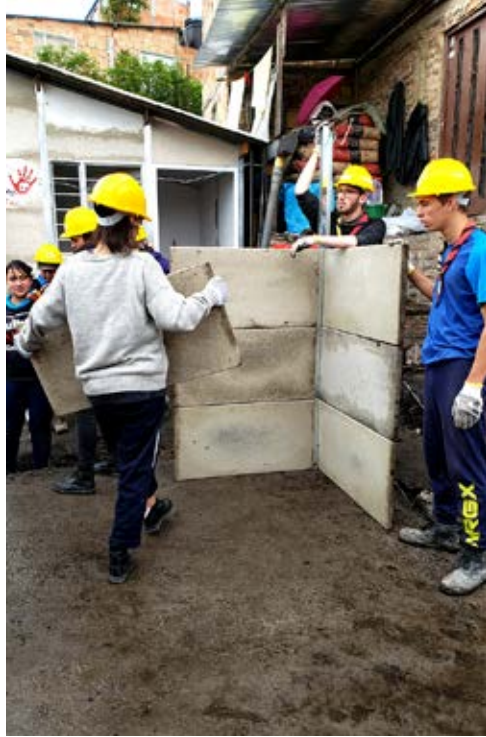
Figura 6. Levantamiento de muros. Fotografía de César Fernández, 2018.
