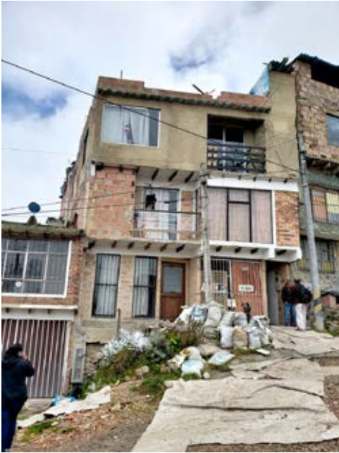
Figura 4. Casa multifamiliar de tres niveles. Fotografía de César Fernández, 2018.
