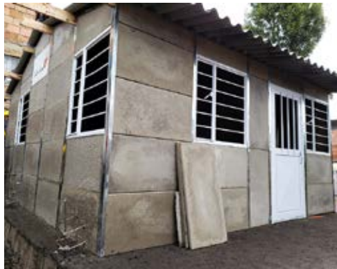
Figura 7. Módulo de vivienda prefabricada. Fotografía de César Fernández, 2018.
