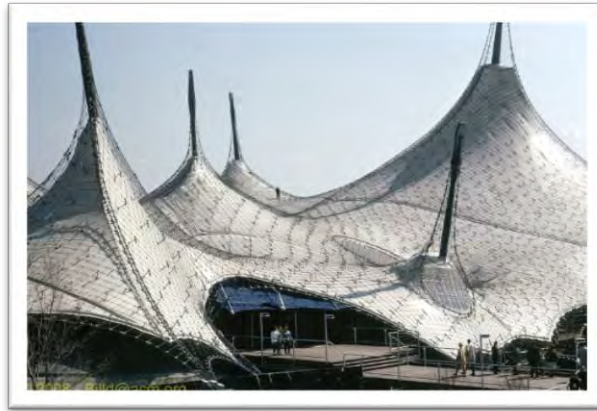
Figura 1.2 Tenso-estructura del pabellón Alemán de 1967 (adaptado de Wikipedia.org)
