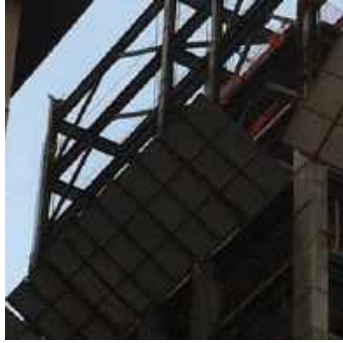
a) Vista durante la etapa de construcción en los últimos niveles del edificio
