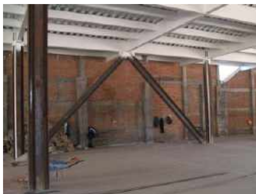
Figura 1.11 — Ejemplo de marco contraventeado concéntricamente
