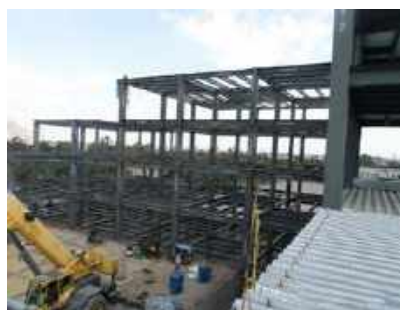
b) Construcción del Hospital Mota-Engil (adaptada de Grupo Baysa)
