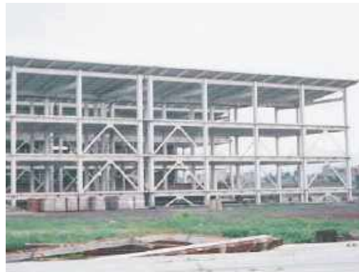
b) Vista de los marcos de acero con contravientos concéntricos
