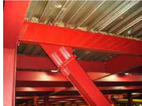
b) Vista del detalle de conexión del contraviento excéntrico (cortesía Tapia, 2014)
