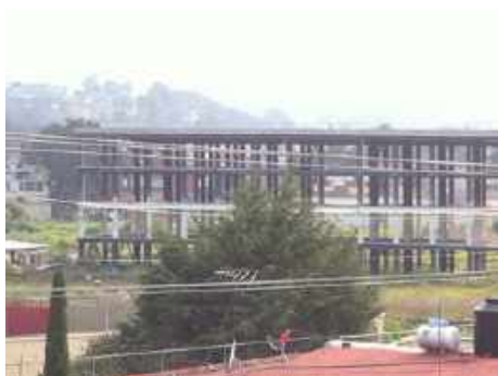
a) Vista general en el sentido largo del edificio
