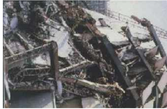
b) Edificio de acero colapsado (adaptada de Tapia y Tena, 2001)
