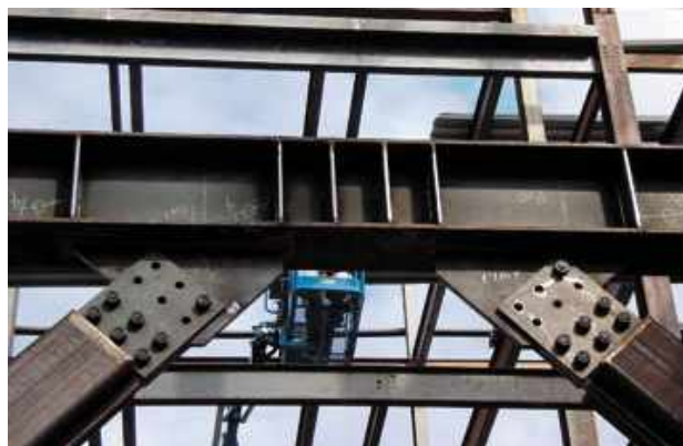
b) Detalle de conexión de contraventeos excéntricos
