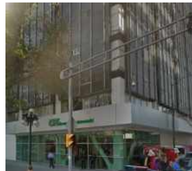
b) Vista en esquina del edificio ubicado en la esquina de Juárez con Humboldt
