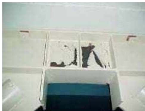
b) Daño por fluencia en la viga enlace en un marco con contraviento excéntrico, dirección este - oeste (adaptada de Filiatrault et al. , 2001)
