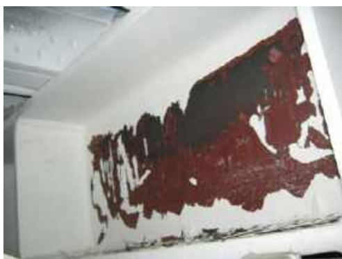
a) Fluencia de la viga enlace en el nivel 3 del edificio Club Tower (adaptada de Clifton et al. , 2011)
