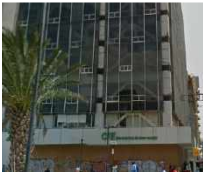
a) Vista lateral del edificio
