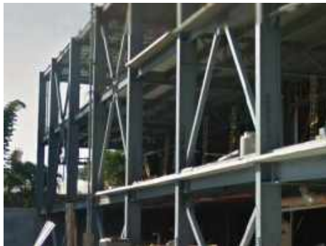
a) Vista de la estructura durante su etapa de construcción
