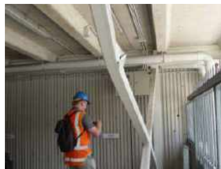
b) Pandeo local en un contraviento concéntrico
