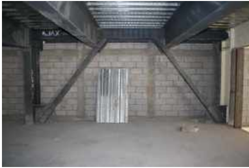
a) Vista lateral del marco contraventado excéntricamente
