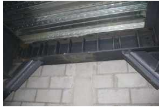
b) Vista del detalle de la viga enlace con sus atesadores centrales
