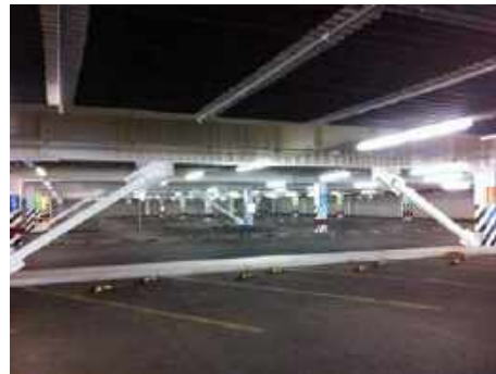
b) Vista lateral del marco contraventeado excéntricamente
