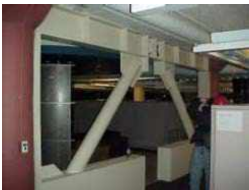
a) Marco de acero contraventeado excéntricamente empleado para mejorar el comportamiento sísmico del edificio Starbucks (adaptada de Filiatrault et al. , 2001)
