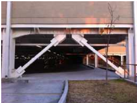
a) Vista lateral del marco contraventeado concéntricamente
