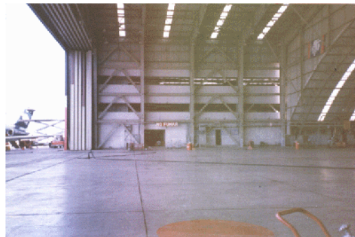
Figura 3.3 — Vista lateral de los marcos de acero contraventeados concéntricamente del edificio de mantenimiento de Aeroméxico
