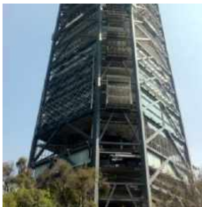
a) Edificio con contraventeos excéntricos, Torre Bancomer - Ciudad de México
