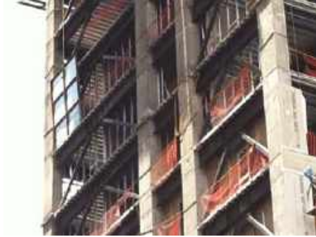
b) Vista de los contravientos excéntricos y las columnas de sección compuesta
