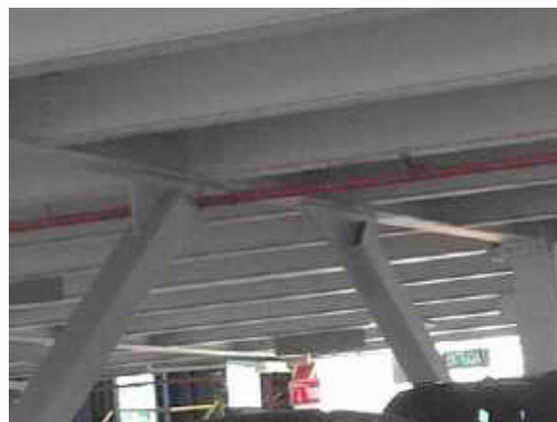
b) Detalle de la viga enlace
