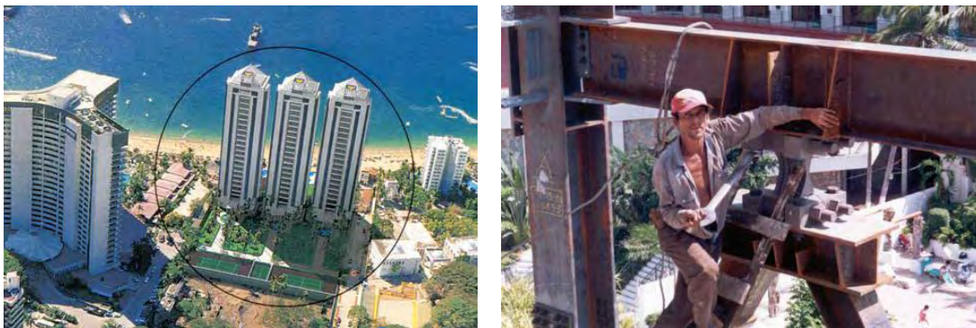
Figura 0.6. Conjunto la Jolla (Cortesía de EMRSA, Tena 2003)
