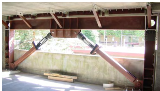
Figura 0.15. Ejemplo de disipador viscoso ( http://www.staaleng.com/seismic_strengthening.htm )
