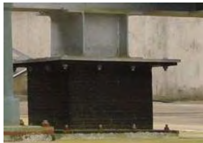
Figura 0.8. Aisladores sísmicos “Robinson” ( http://www.seismicisolation.com/ )
