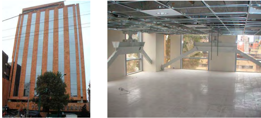
Figura 0.4. Reestructuración del edificio Torre Monterrey (fotos cortesía de EMRSA, Tena 2003)
