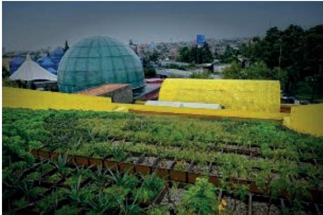
Imagen 2. Azotea verde en Papalote museo del niño Técnica de Macetas de plástico recicladas (México, D.F). ( http://www.efectoverde.org/es/proyectos/papalote_museo_nino.html ).
