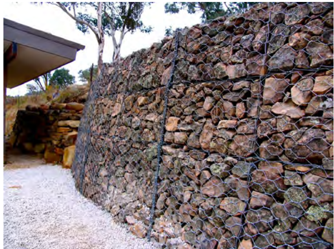
Figura 8.2: Muro de contención a partir de gaviones de piedra, Fuente: http://milkwood.net/
