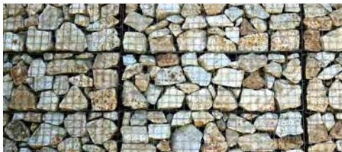
Figura 8.1: Arriba, superficie porosa reportada en los nidos de Macrotermes Michaelseni (Turner y Soar, 2008). Abajo, muro a partir de gaviones. Fuente: inhabitat.com
