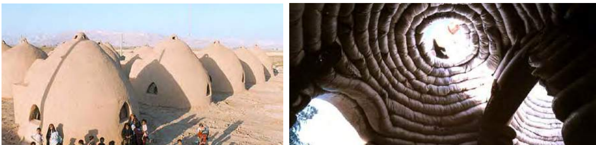
Figura 6.12: Albergues a partir del sistema "superadobe" de Nader Khalili. Estas construcciones aprovechan la inercia térmica de la tierra. El enfriamiento convectivo que producen los vientos sobre la envolvente y la salida del aire caliente al interior por medio de la estratificación térmica. Fuente: http://calearth.org
