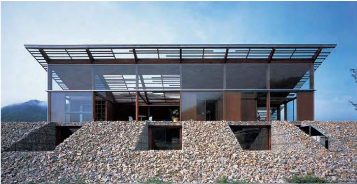
Figura 10.7: Fachada posterior de la Stone House de Sambuichi Architects . Fuente: www.japan-architect.co.jp
