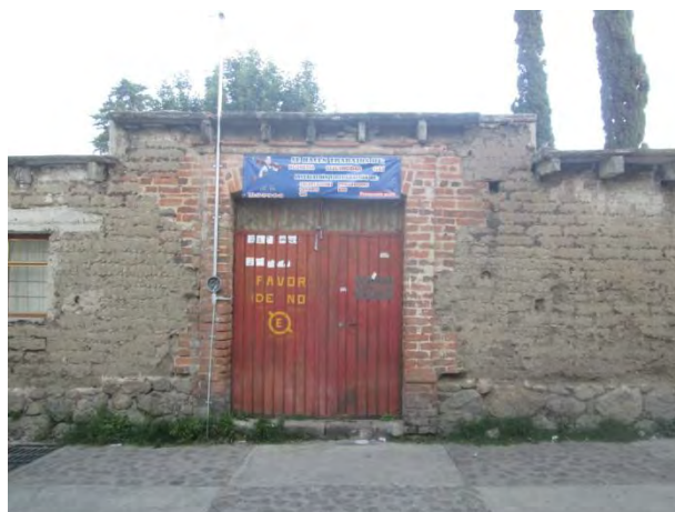
Fotografía 113. Fachada sur, sobre Guerrero: 2018
