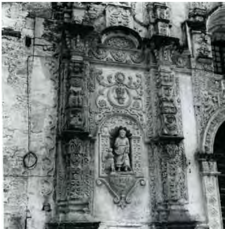
Fotografía 11. Detalle de portada principal. CNMH, 1960
