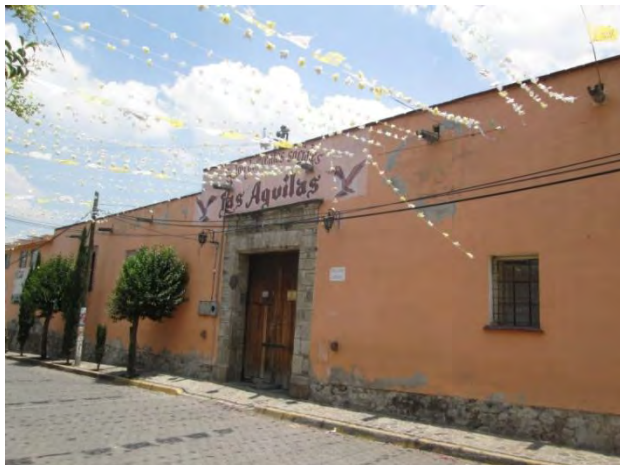
Fotografía 175. Fachada sur, salón de eventos Las Águilas: 2018.
