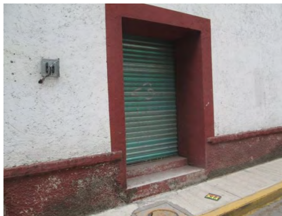
Fotografía 123. Local comercial, muro original siglo XIX
