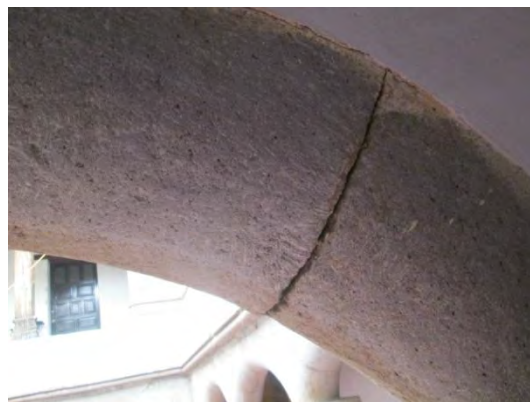
Fotografía 188. Juntas en arcos de cantera del claustro bajo, San Luis Obispo: OMA: 2018
