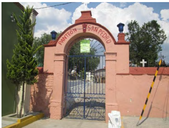
Fotografía 162. Arcos del acceso al panteón de San Pedro, siglo XIX
