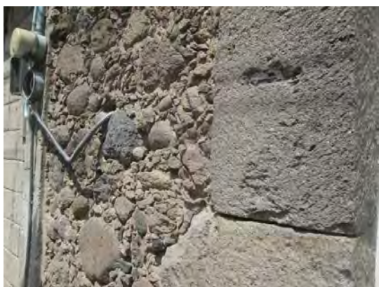
Fotografía 81. Detalle de añadido discordante y estereotomía
