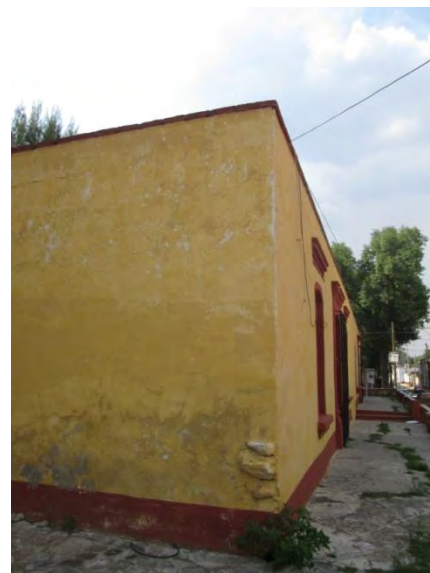
Fotografía 126. Estructura de adobe y mampostería, actual biblioteca: 2018
