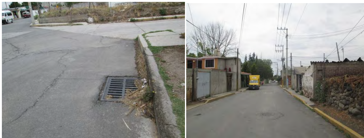
Fotografía 200. Pozos de visita y trampas de tormenta, calle Emiliano Zapata esquina con camino Real, San Luis Huexotla: Omar Mendoza Arias: 2017.
