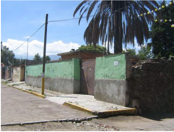
Fotografía 7. Calle San Francisco, vista desde la esquina con Aztecas, se requiere del tratamiento de piso, con materiales que permitan la absorción del agua de lluvia, además de la instalación de una gestor de tormenta, para recibir el agua que baja sobre San Francisco, para evitar el deslave de la muralla en su base y núcleo, y redirigir el agua rodada hacia el río San Bernardino o de la Virgen, *Nota: no se deben cambiar pisos sin la supervisión y autorización del INAH: OMA:2017
