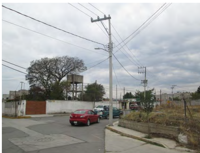
Fotografía 201. Pozos de visita, calle Emiliano Zapata esquina con camino Real, SanLuis Huexotla: Omar Mendoza Arias: 2017.
