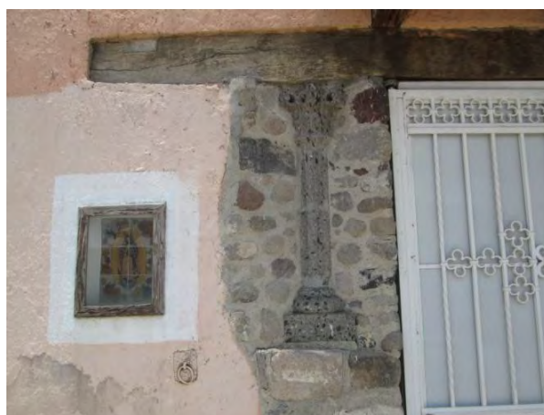
Fotografía 109. Detalle de pilastras adosadas en portal de acceso, probable siglo XVI, XVII
