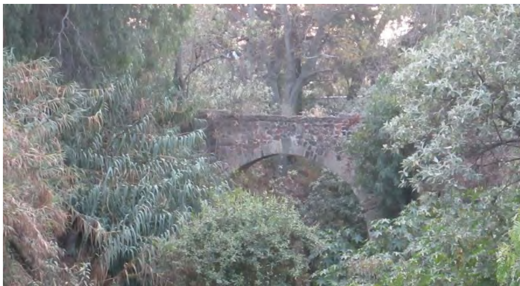
Fotografía 26. Acueducto prehispánico de Nezahualcóyotl en Huexotla, restaurado con piedra de tezontle en época virreinal
