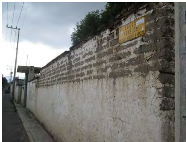
Fotografía 35. Detalle de muro de adobe, probable siglo XIX, XX: 2018
