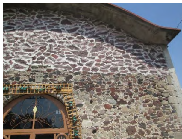
Fotografía 161. Detalle de intervenciones y sistema constructivo
