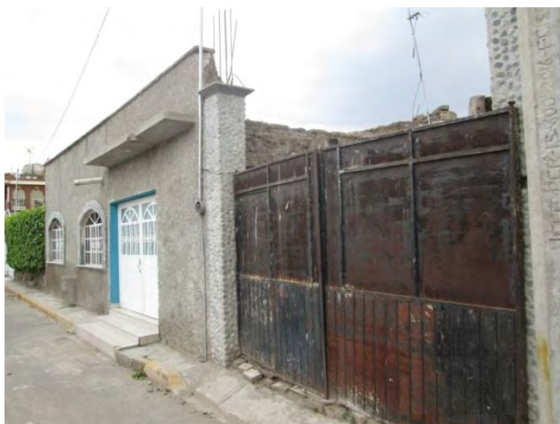
Fotografía 141. Demolición y desaparición de monumento: 2018
