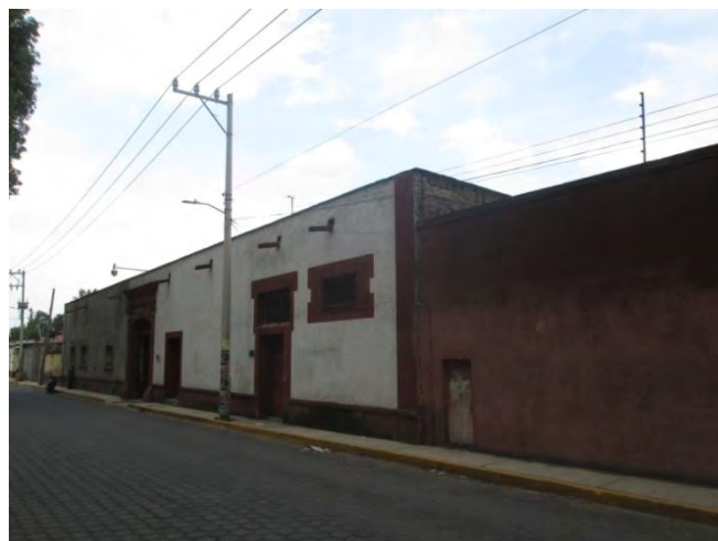
Fotografía 119. Fachada lado poniente, vista hacia el norte: 2018
