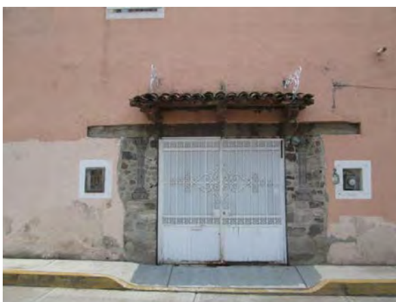
Fotografía 108. Portal de Fachada norte sobre Miguel Domínguez
