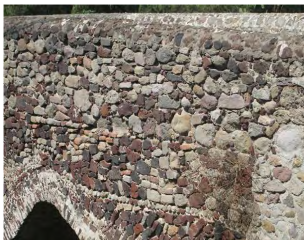
Fotografía 85. Estereotomía en puente virreinal
