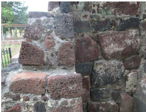
Fotografía 155. Detalle de estereotomía en basamento de tezontle rostriado
