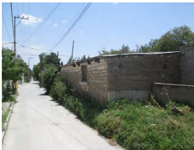
Fotografía 40. Casa habitación, estructura siglo XIX, sobre independencia: 2018
