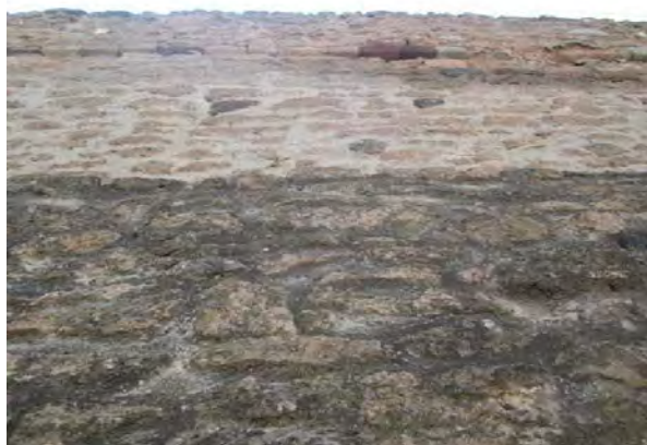
Fotografía 11. Estereotomía en muralla prehispánica, se aprecian sobre la muralla, las marcas del agua del nivel que tenía el lago de Texcoco y la intervención de consolidación en la parte superior de la Arqueóloga María Teresa en 2006
