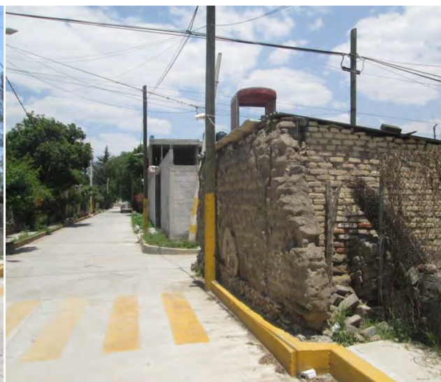
Fotografía 45. Vista de estructura probable siglo XIX, sobre Buenavista hacia el oriente: 2018
