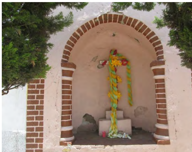
Fotografía 92. Falta de limpieza y mantenimiento
