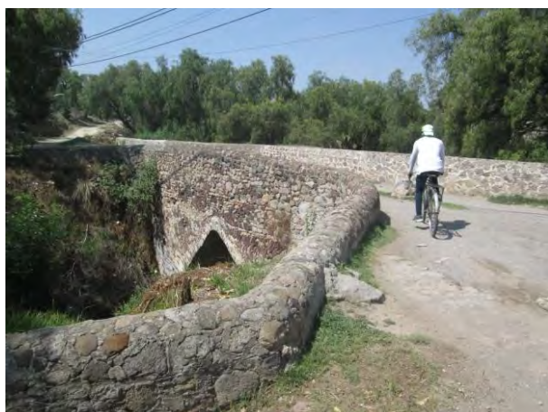
Fotografía 84. Puente virreinal siglo XVI: 2018
