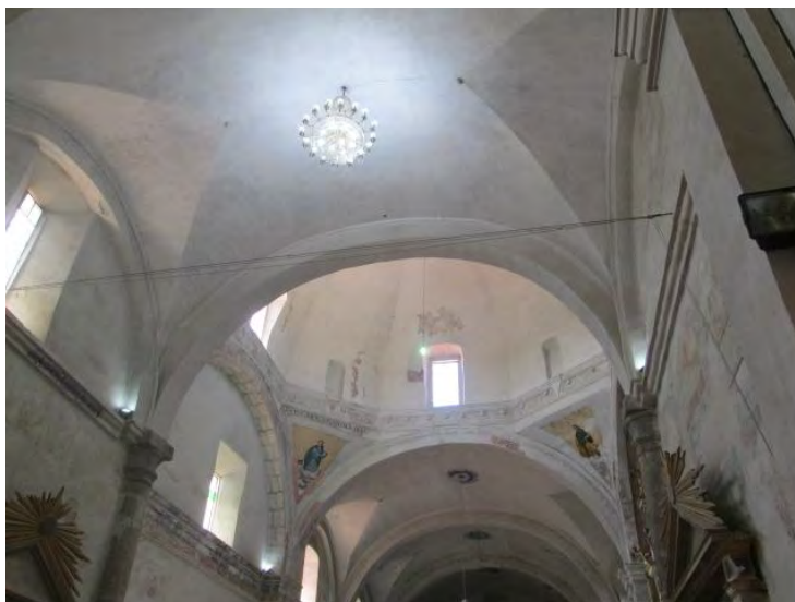
Fotografía 181. Bóveda de arista del Templo de San Luis Obispo
