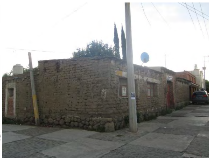
Fotografía 111. Estructura de tierra sobre Guerrero: 2018
