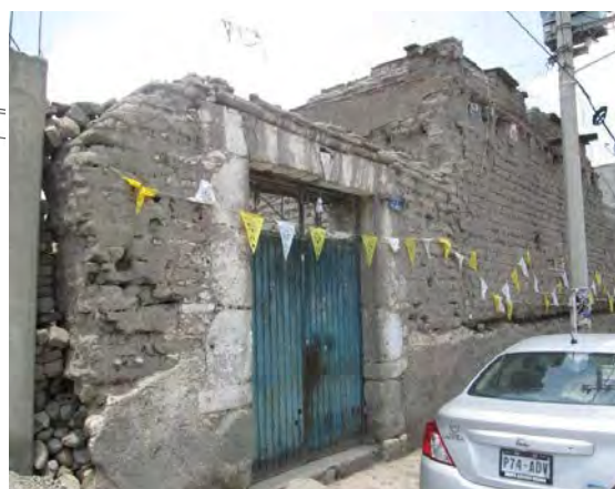
Fotografía 48. Fachada casa habitación, estructura de tierra siglo XIX
