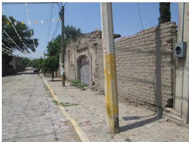
Fotografía 75. Muro de tierra (adobe), Aztecas esquina con San Francisco
