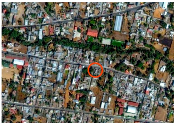
Fotografía 137. Estructura de tierra, muros en portada de adobe probable siglo XIX
