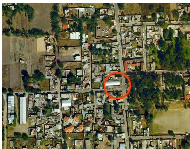
Fotografía 173. Vista aérea, Las Águilas estructura del siglo XIX
