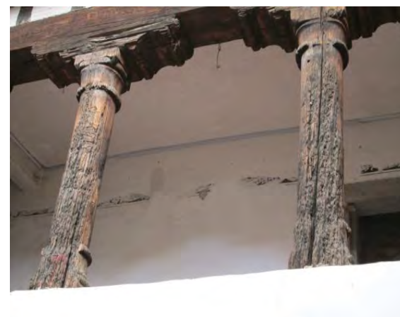
Fotografía 103. Detalle de columnas de madera en el Claustro alto, siglo XVI, XVII
