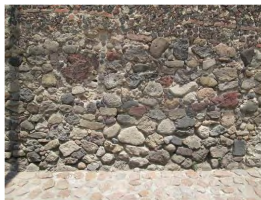
Fotografía 82. Detalle de recubrimiento de piedra de tezontle con cemento y rodapié de mampostería
