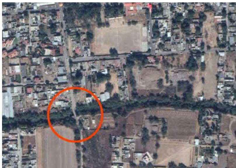
Fotografía 83. Puente colonial siglo XVI, localización vista aérea
