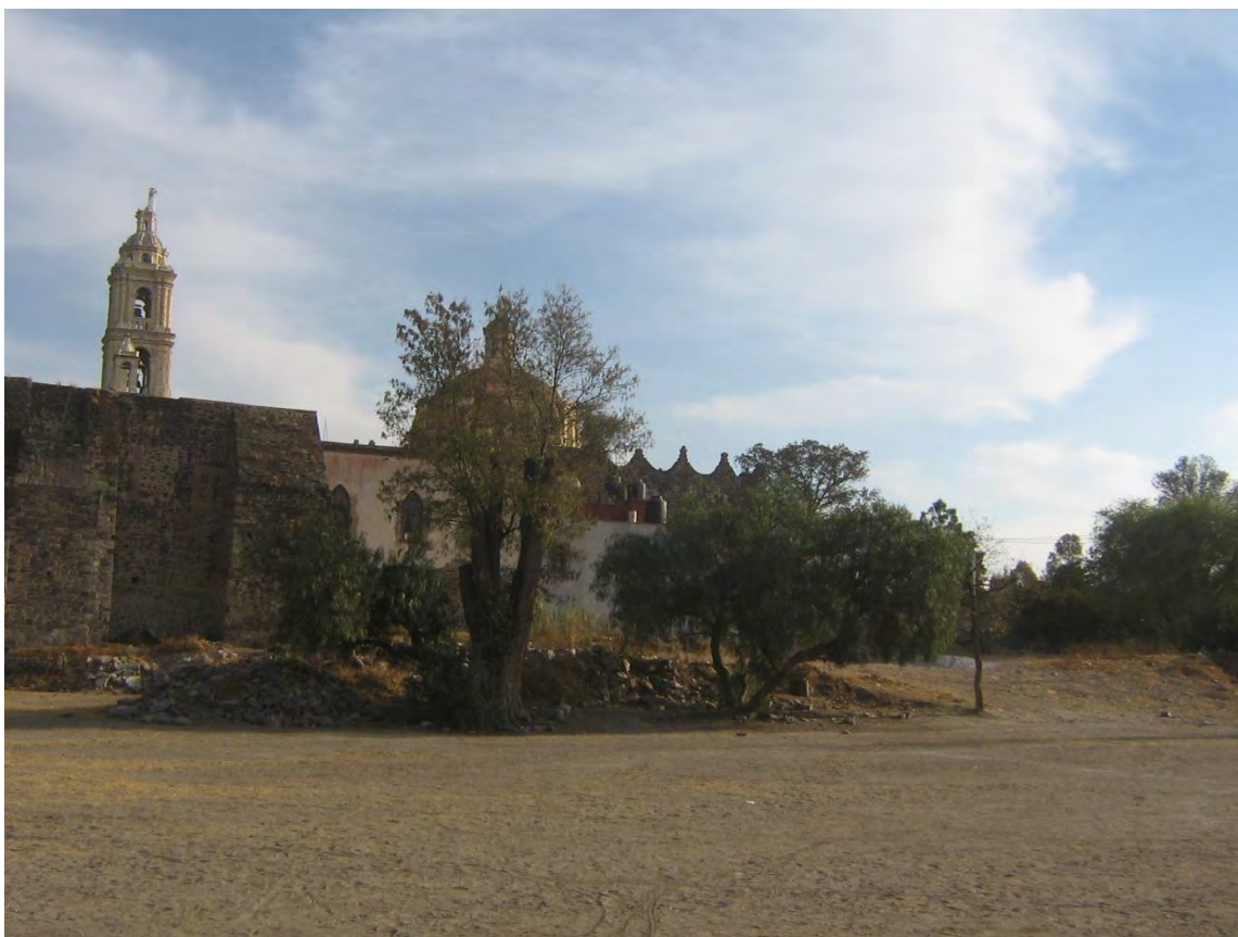
Fotografía 17. Templo de San Luis Obispo Templo de San Luis Obispo, limpieza y retiro de escombros, con recuperación de piezas de cantera y vestigios de columnas del siglo XVI.
