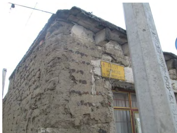
Fotografía 112. Detalle de fábricas, losa de concreto armado
