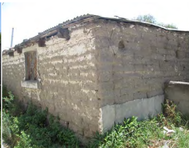
Fotografía 41. Detalle de estructura de tierra, probable siglo XIX: 2018
