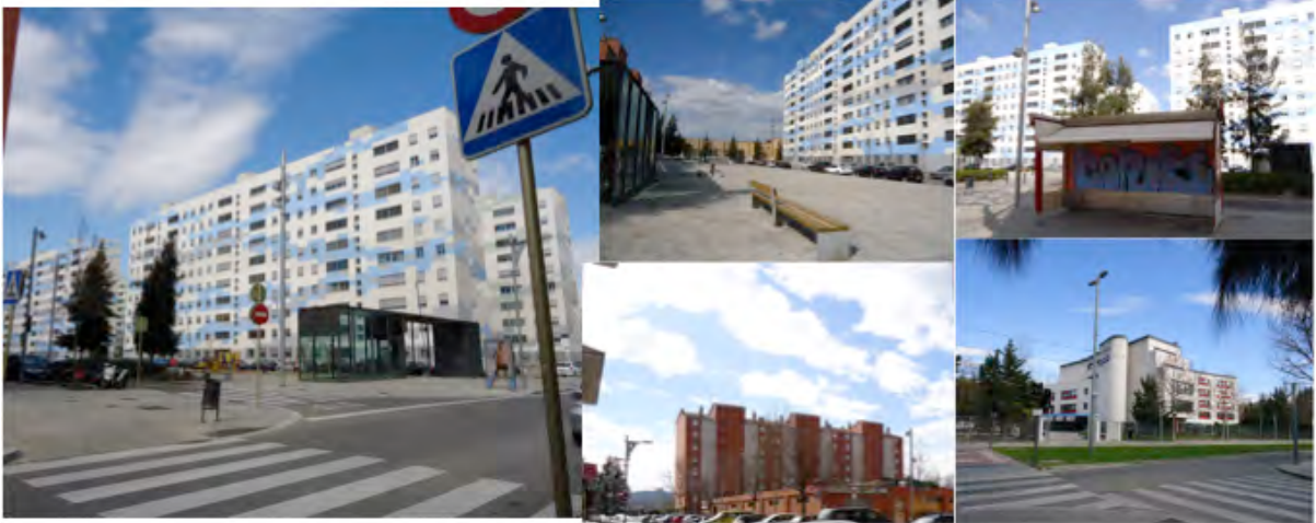
Figura 4.9 Rehabilitación de vivienda protegida
