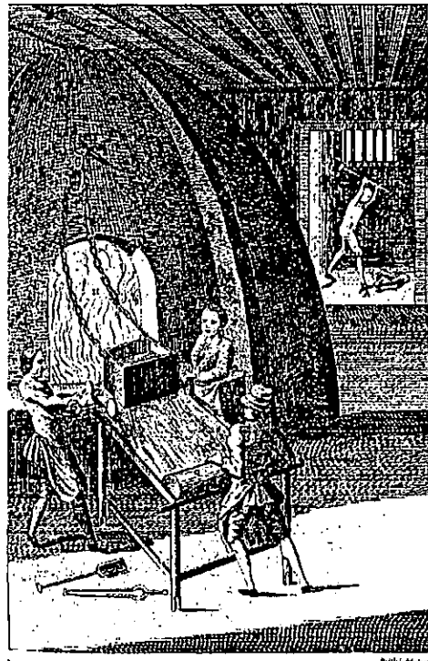
Fig. 1.14 El primer método de fabricación de vidrio plano como fluido en movimiento 1688-1702 56 .
