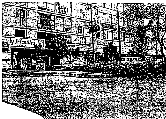
Foto 12. Colonia Viaducto Piedad. Desplazamiento de vivienda por uso comercial y de servicios (sep.97)
