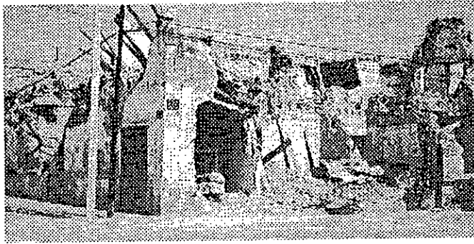
Fig. 176. Vecindad destruida en la Ciudad de México, 1985. (Foto AGP)
