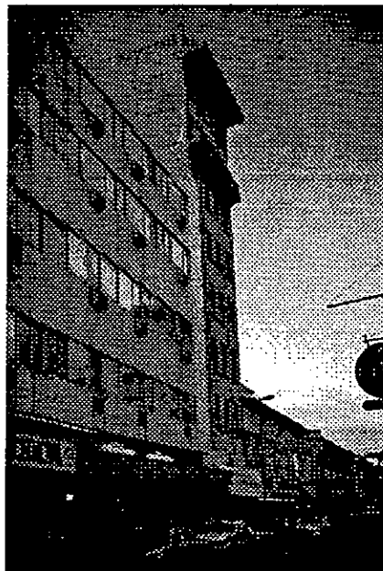
Fig.10. Tampico. Edificio de 9 pisos de 1919
