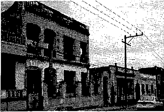
Fig. 116. Residencia de mampostería con deterioros evidentes.
