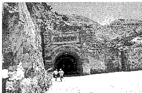
Fig 102 Túnel de Ogarrío.
