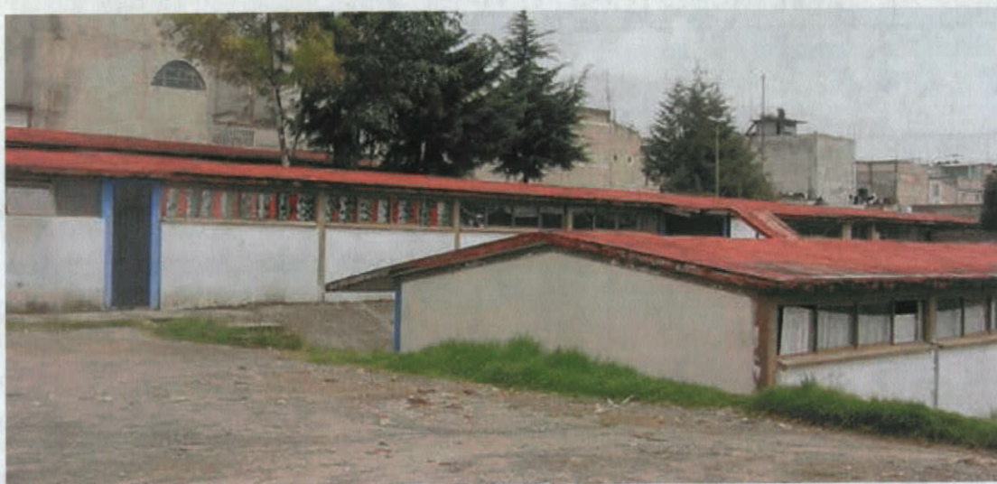
Figura 32 Construcción de plantel en terrazas Lugar: Col. Valle Dorado, Naucalpan, Edo. Méx. Fecha: Sep.2002 Hora: 15:00 Hrs.
