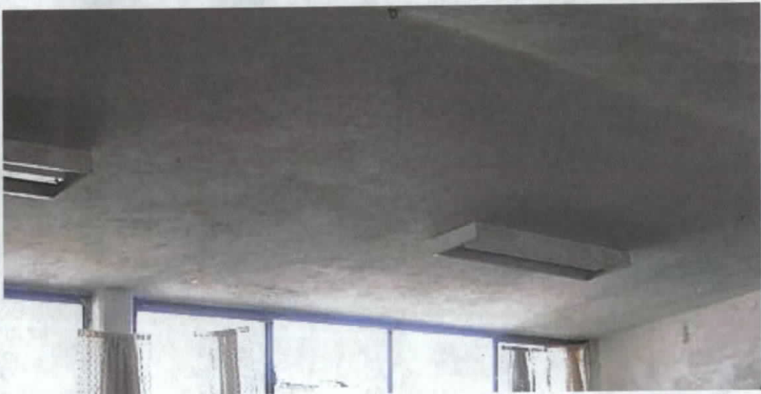
Figura 99 El color blanco de alta reflectancia de uso en plafones favorece los niveles de iluminación al interior de las aulas.
