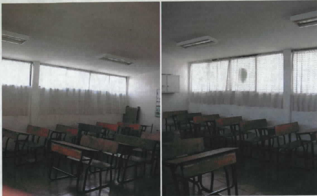
Figura 92 Condiciones de iluminancia natural al interior de aula de aplicación en plantel Azuela
