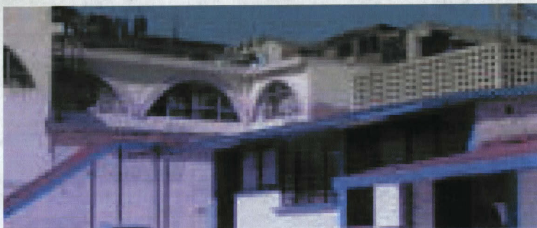
Figura 23 Terraza de acceso principal: oficinas directivas Lugar: Col. Valle Dorado, Naucalpan, Edo. Méx. Fecha: Nov.2001 Hora: 11:05 Hrs.
