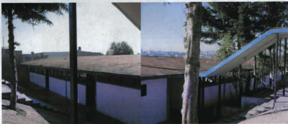
Figura 26 y 27 3ª Terraza: salones de cuarto grado(izq.), sanitarios(centro) y salones de tercer grado(der.) Lugar: Col. Valle Dorado, Naucalpan, Edo. Méx. Fecha: Nov.2001 Hora:11:15 Hrs.
