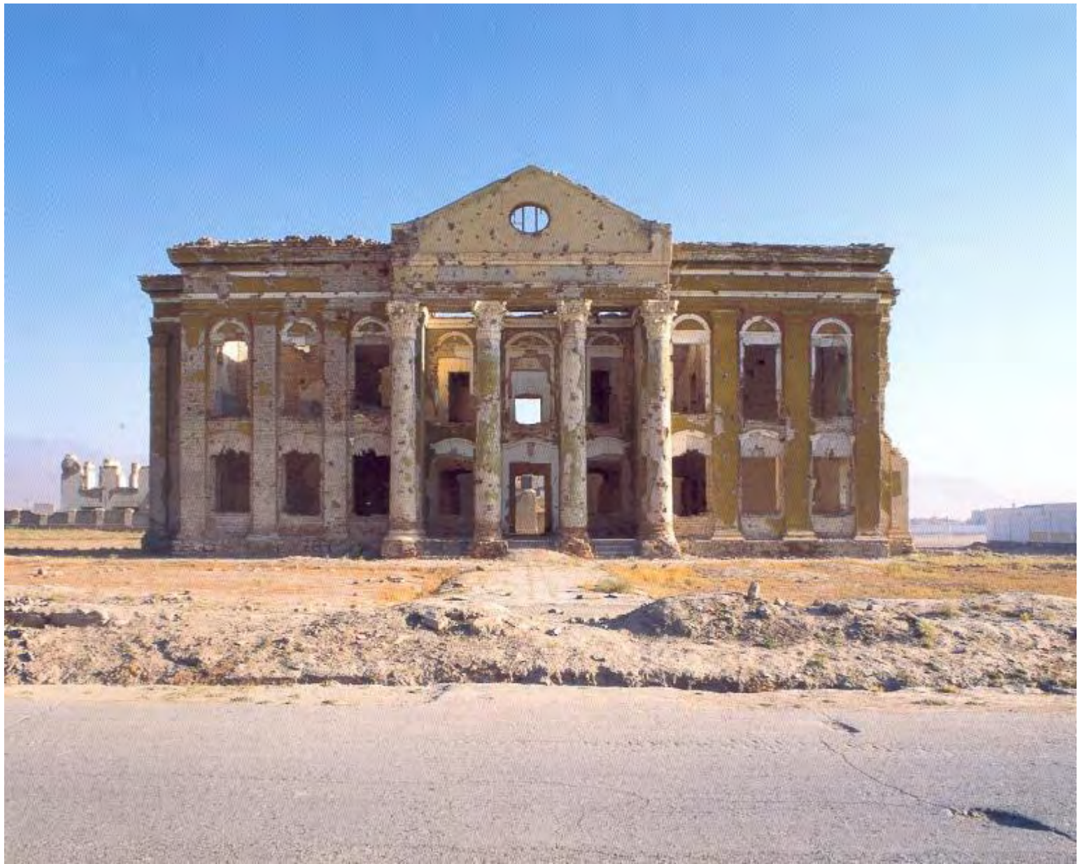
Un edificio del gobierno en la nueva ciudad satélite Darulaman / Kabul
